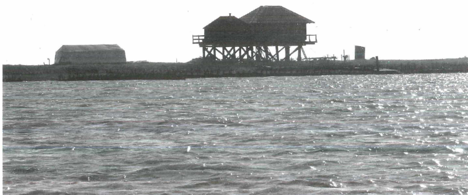
Zur Rohbau-Abnahme am 31.3.05 war endlich strahlend schönes Wetter.
