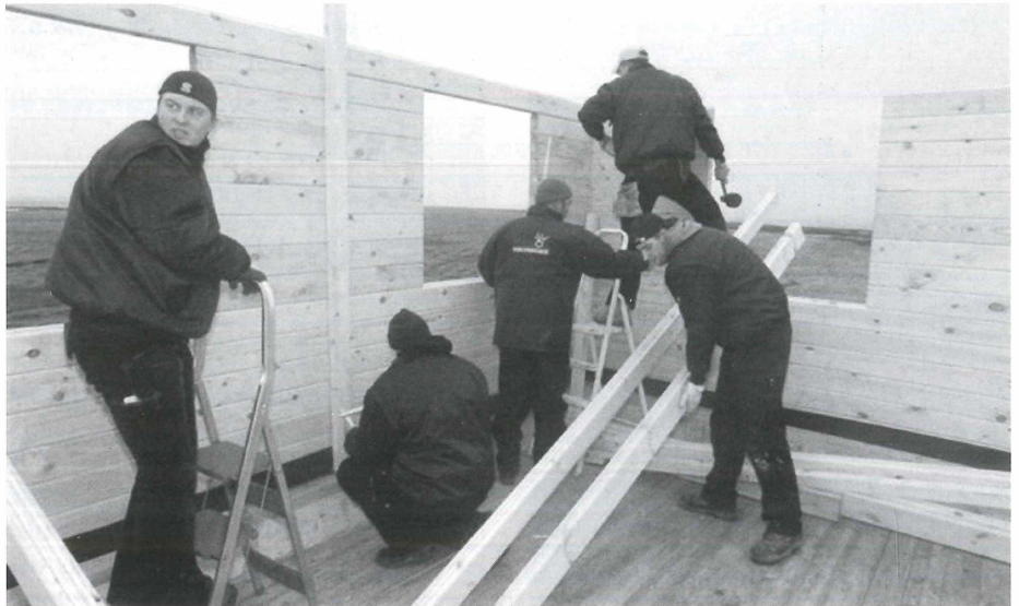
Bei Wind und Wetter wird gebaut, was das Zeug hält
