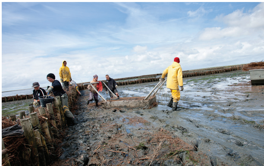
Wichtigste Arbeit im Küstenschutz auf Norderoog ist der Lahnungsbau.
