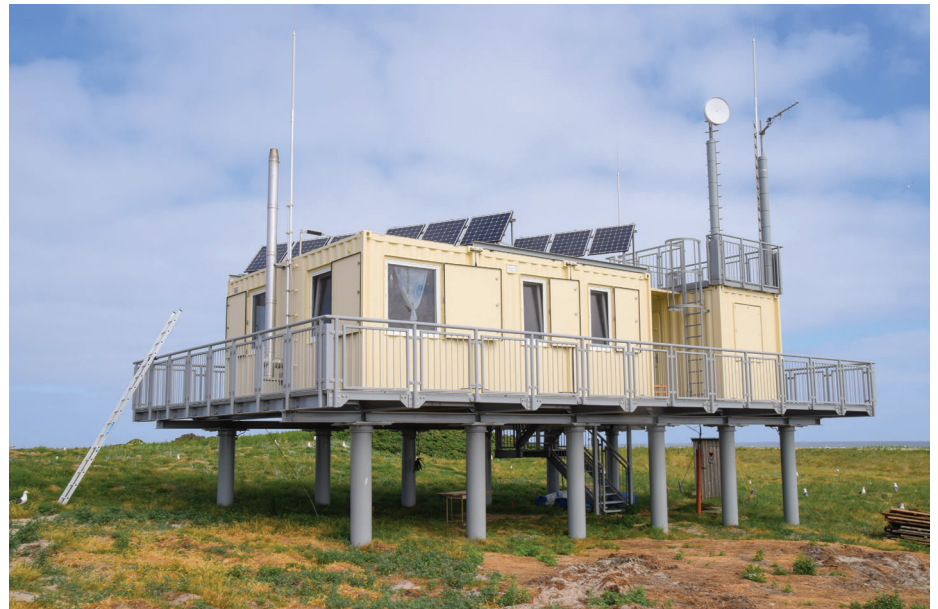
Die neue Vogelwärter- und Windmess-Station.
