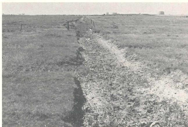
Abb. 17: Neuer langer Entwässerungsgraben im Vorland parallel zum Deich. 21. 7. 82.
