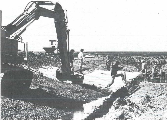
Die starkbeschädigte Westspitze erhält im Herbst 1977 eine stabile Schüttsteinkante. Foto: Harro Müller
