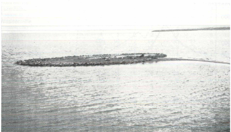
Die sechste Steininsel wird sehr gut von Seeschwalben (1985: ca. 70 Gelege), Lachmöwen (1985: 10 Gelege) und Säbelschnäblern als Brutplatz genutzt. Auch hier ist bereits ein deutlicher Sandabtrag zu erkennen (hinterer Teil der Insel).
