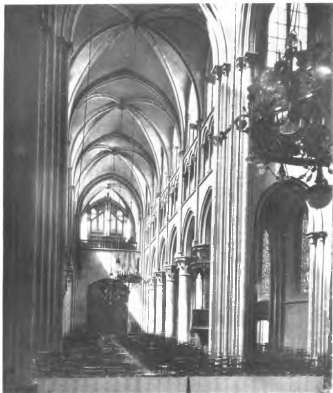
Dijon, Frauenkirche, Blick in das Langhaus
