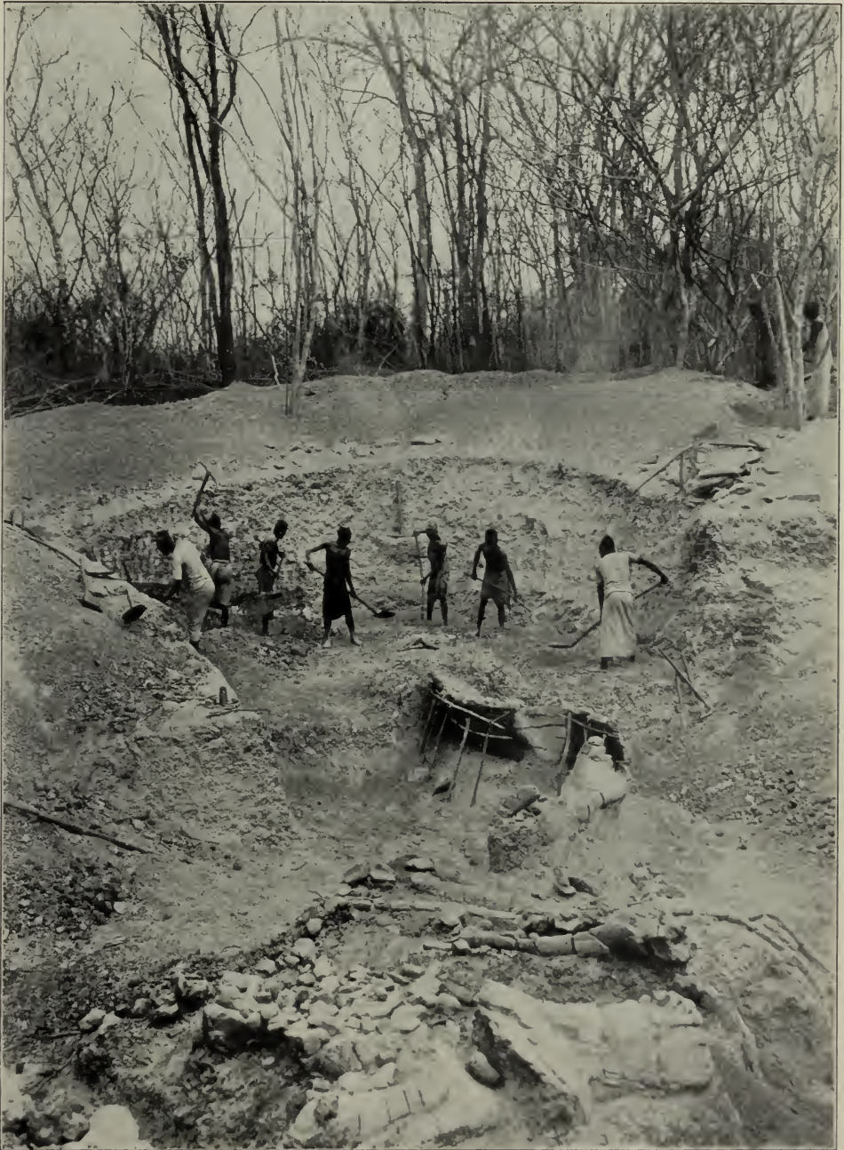
Arbeit in einem Graben.
