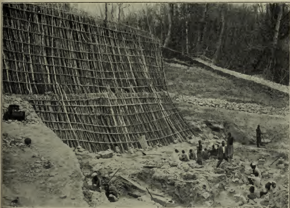
Fig. 3. Ausschachtung an dem Fundplatze des größten Dinosaurierskelettes.
