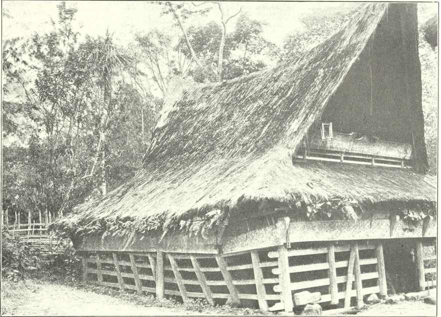
Abb. 4. Schöngeziertes Pakpak-Holzhaus. Vorn ist die Laufgalerie deutlich sichtbar. (Aus Volz, Nord-Sumatra I.)
