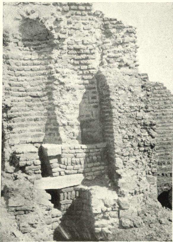
Fig. 1. Abortanlage eines Hauses zu Fustât . Links der Sitz aus Kalksteinplatten mit schlitzförmiger Öffnung, rechts daneben der Abflussschacht des Aborts vom oberen Stockwerk. Unter beiden links der Abflussschacht.
