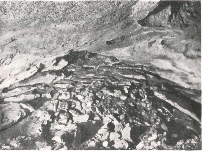
Fig. a. Maximilianshöhle bei Krottensee. Bogenförmiger Plattenbruch (Sprengschalen) mit Gewölbedecke im dickbankigen Frankendolomit. Man beachte die glatt durchschnittenen Sickerwasserkolke in der rechten Deckenpartie.
