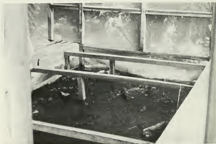
Abb. 4 Emergenzhaus, Innenansicht bachaufwärts.
