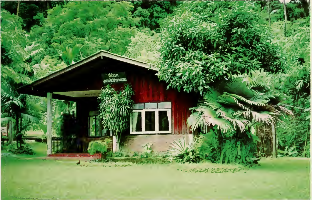
Abb. 8.2. Blick auf das Haus der Park-Verwaltung am Tone Soi-Wasserfall (Khao Phra Thaew-Park, Phuket, Thailand)
