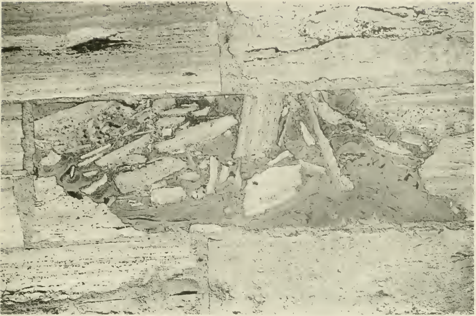
Abb. 6. Travertinplatten in durch Calciumkarbonat verfestigtem Ocker. Werkstein in der westlichen Außenfassade der ehemaligen Versandhalle der Firma Lauster.
