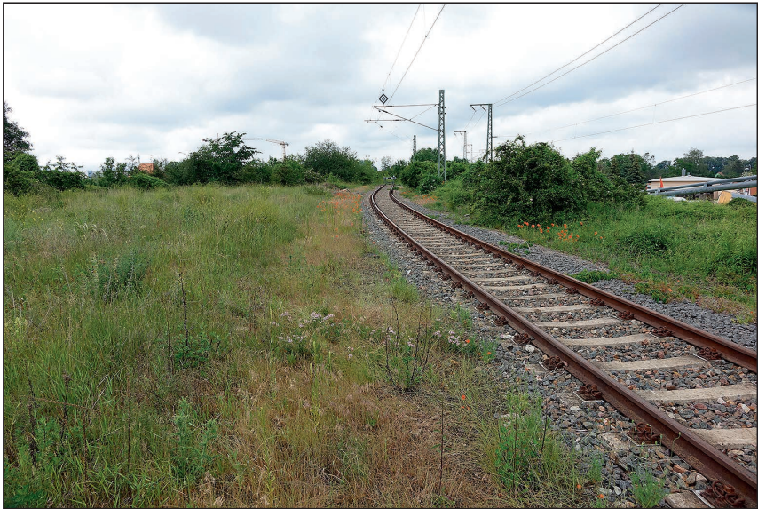
Abb. 7: An den Fundort von Leptophyes albovittata schließen sich in südlicher Richtung weitere Brachflächen an. Die Abbildung zeigt eine vor wenigen Jahren teilsiegelte Bahntrasse. Das vegetationsfreie Schotterbett der wenig frequentierten Nebengleisanlage rechts im Bild einschließlich seiner sandig-kiesigen, kurzrasigen Randbereiche bereichert das Lebensraumangebot für thermophile bzw. geophile Orthopteren. (Foto: M. Krech, 05.07.2020, Gleisknoten westl. Kalkreife, Erfurt-Ost).
