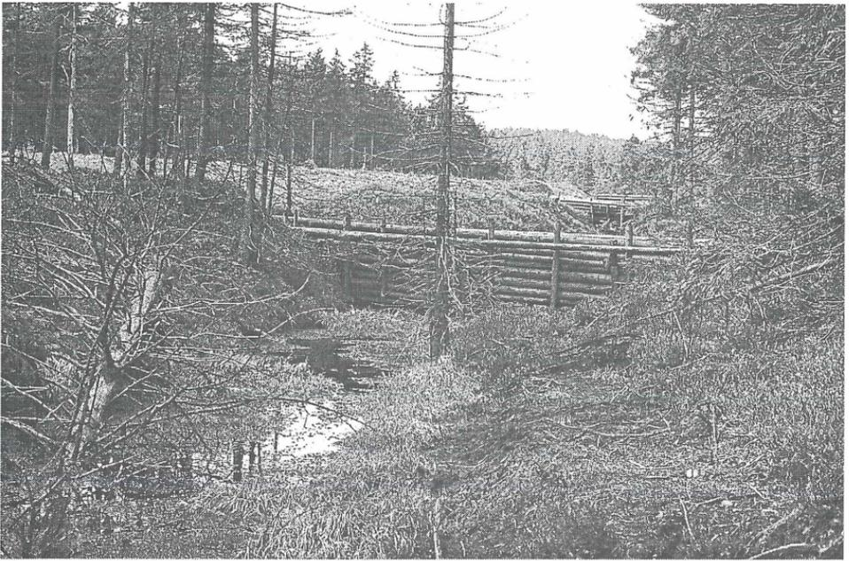
Foto 1: Blick von Nordosten auf die Stauwerke im Hauptentwässerungsgraben („Seegraben“) des Saukopfmoores. Aufgrund des trockenen Frühjahrs 1996 war der Wasserstand fast den ganzen Sommer hindurch ausgesprochen niedrig.
