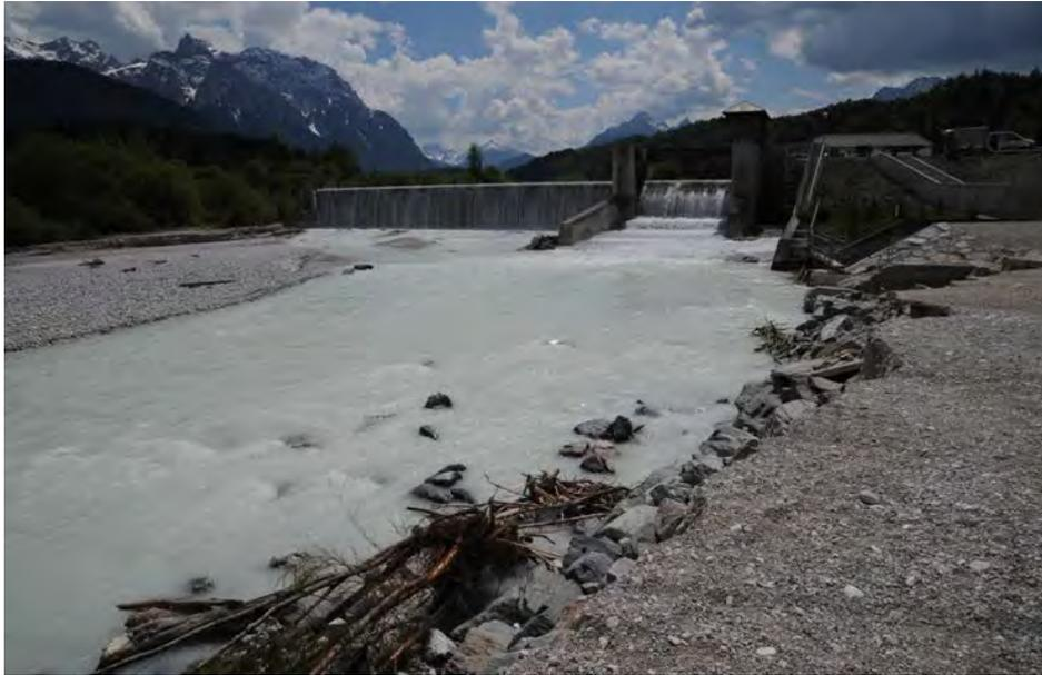
**Abb. 9.** Krüner Wehr, das zur Ausleitung einer Wassermenge von bis zu  $25\text{ m}^3/\text{s}$  über einen Kanal in den Walchensee gebaut wurde (7. Juni 2013; Foto P. Poschlod).
