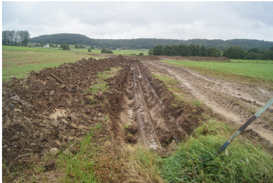
Abb. 18. Wiederherstellungsmaßnahmen sind dringender denn je. Hier erfolgt die Entnahme von Drainagen zur Wiedervernässung (Foto: SICONA, 2017).
