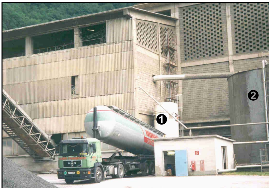
Abbildung 23: Tiermehlübernahme im Zementwerk Peggau; ① Baustellensilo für die Lagerung von Tiermehl; ② bestehender Schweröltank für die Lagerung von Tierfett
