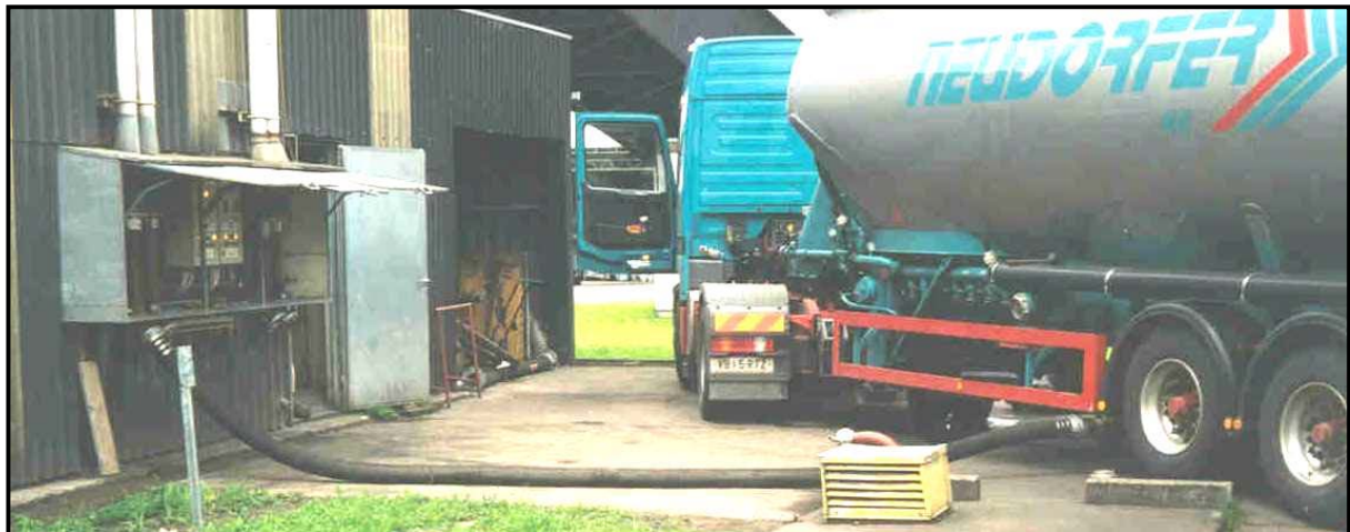
Abbildung 29: Tiermehlübernahme im Kraftwerk Timelkam II
