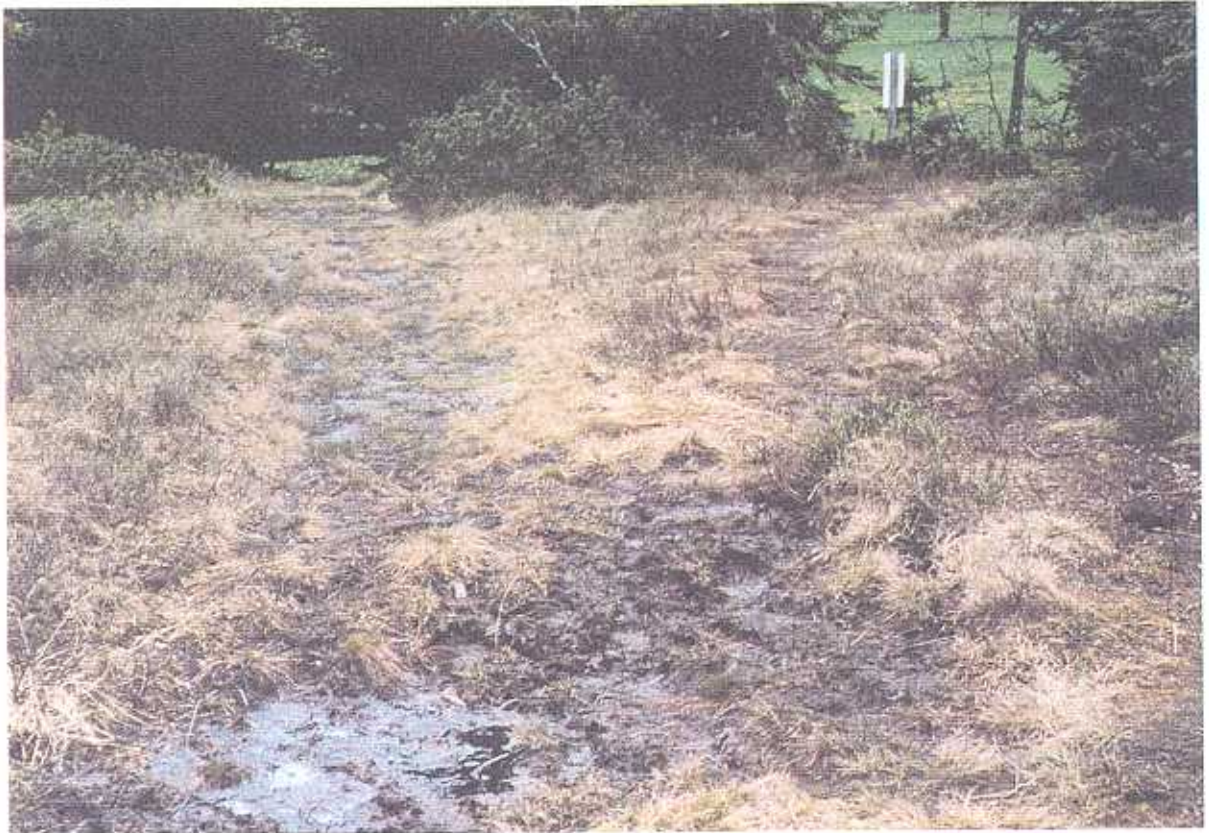
11. Moorzerstörung durch Langlaufloipe und Fußweg im Naturschutzgebiet "Fohramoos"
