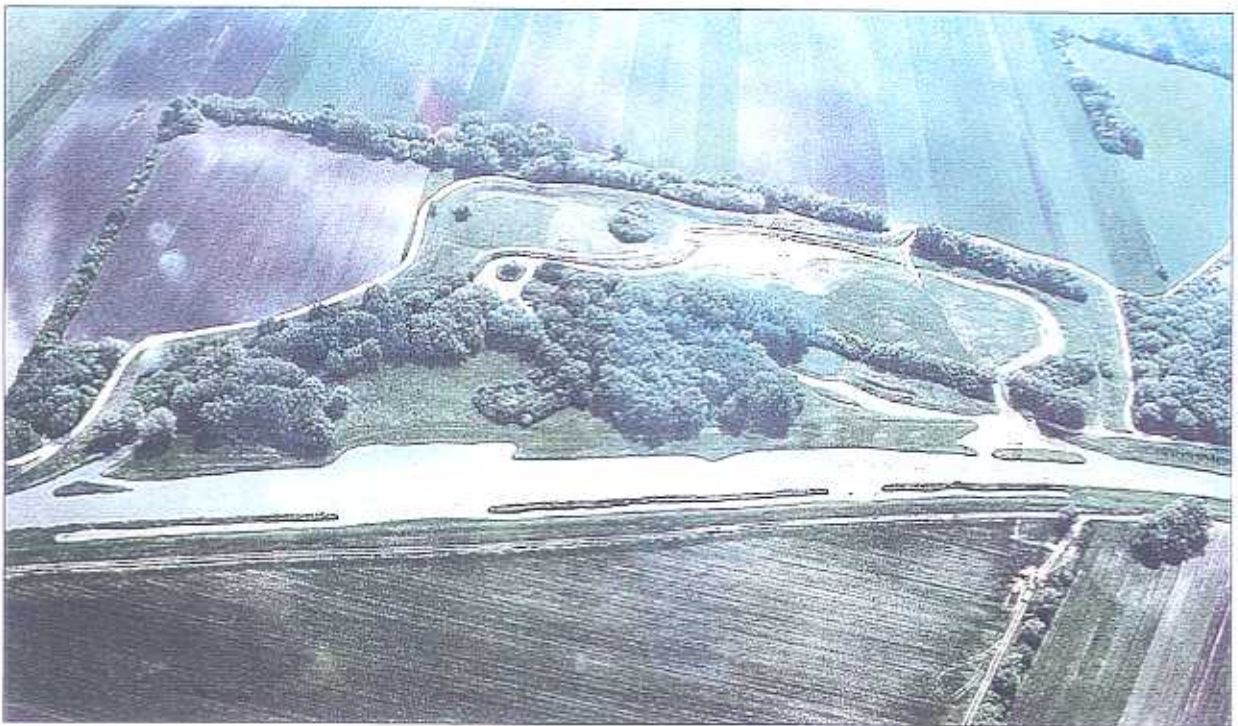
Das Rückhaltebecken in Zurndorf an der Leitha (Burgenland) nach Fertigstellung im September 1991. Beispiel für Strukturierungsmaßnahmen an einem kanalisiertem Tieflandfluß und einer lokalen Aufweitung des Retentionsgebietes. Foto: R. Ivancsics
