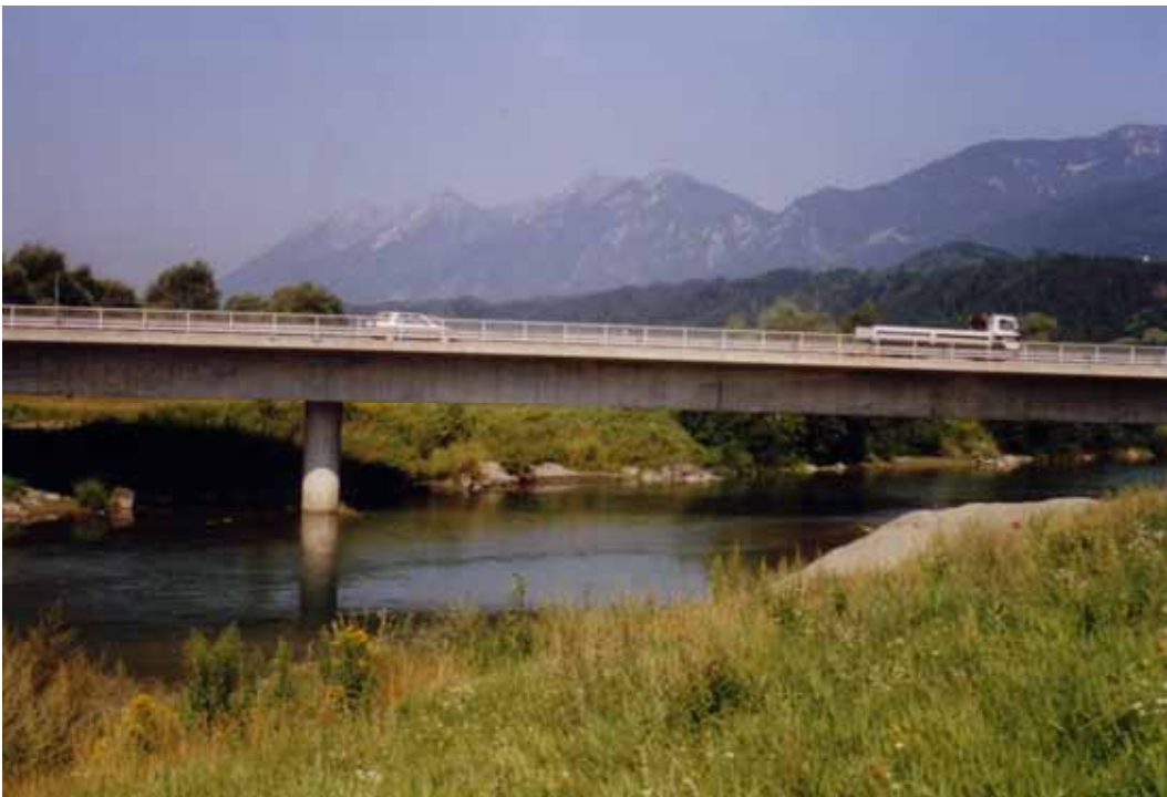
Brücken über Flüsse bilden oft die letzte geeignete Querungsmöglichkeiten unter Verkehrsachsen, allerdings muss auch eine Anbindung an die bewaldeten Hanglagen gegeben sein, damit sie genutzt werden können. (Foto: Martin Ofner)
