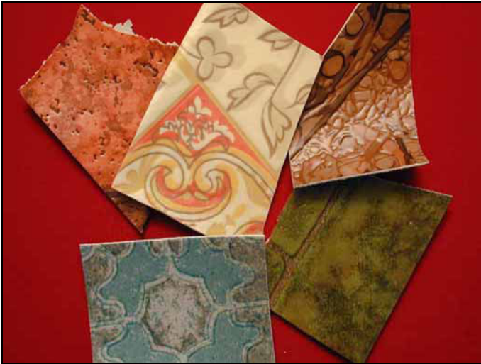
Foto 8: Vinylbodenplatten mit Asbestfasern an der Unterseite (SUVAPRO 2007).
