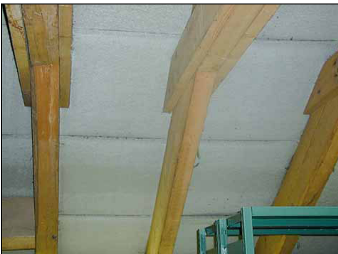
Foto 5: Dach mit Faserzementplatten innen isoliert (SUVAPRO 2007).
