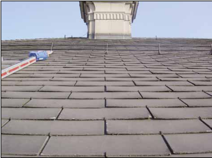
Foto 3: Dach mit Asbestzementschindeln (Eternit) gedeckt (SUVAPRO 2007).
