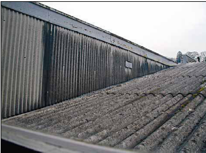
Foto 4: Welldach mit asbesthaltigen Faserzementplatten (SUVAPRO 2007).
