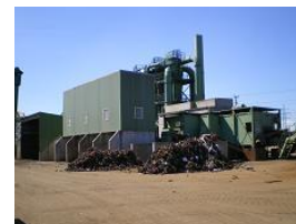
Shredder mit Abwurfbunker
