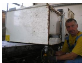
Stufe I, Absaugung des Kältemittels
