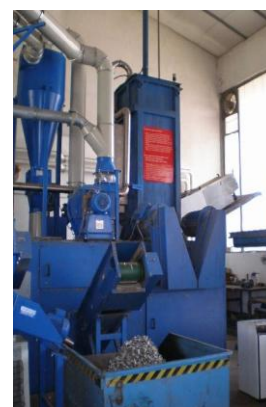
Stufe II, Aufgabe der Geräte in Shredder
