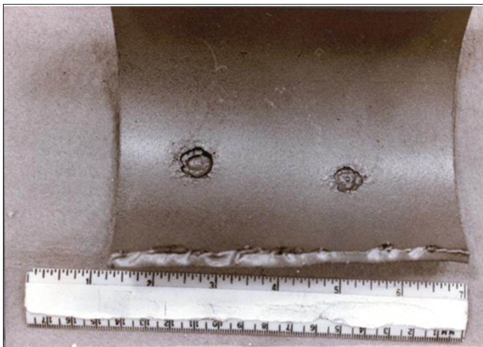
Abbildung 6: Mikrobiell induzierte Korrosion an einem Pipeline-Rohr (© mit freundlicher Erlaubnis des Petroleum Recovery Research Centre, New Mexico).
