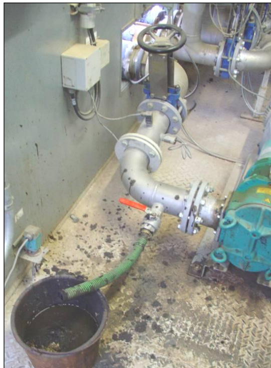
Abbildung 11: Gärrestentnahme über Bypass-Einrichtung. © Bundesgütegemeinschaft Kompost e. V. 2009.
