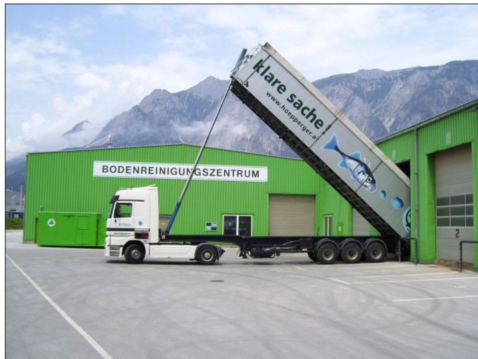
Abbildung 3: Ökotechna – Anlieferung der 300.000sten Tonne (© ALTEC).
