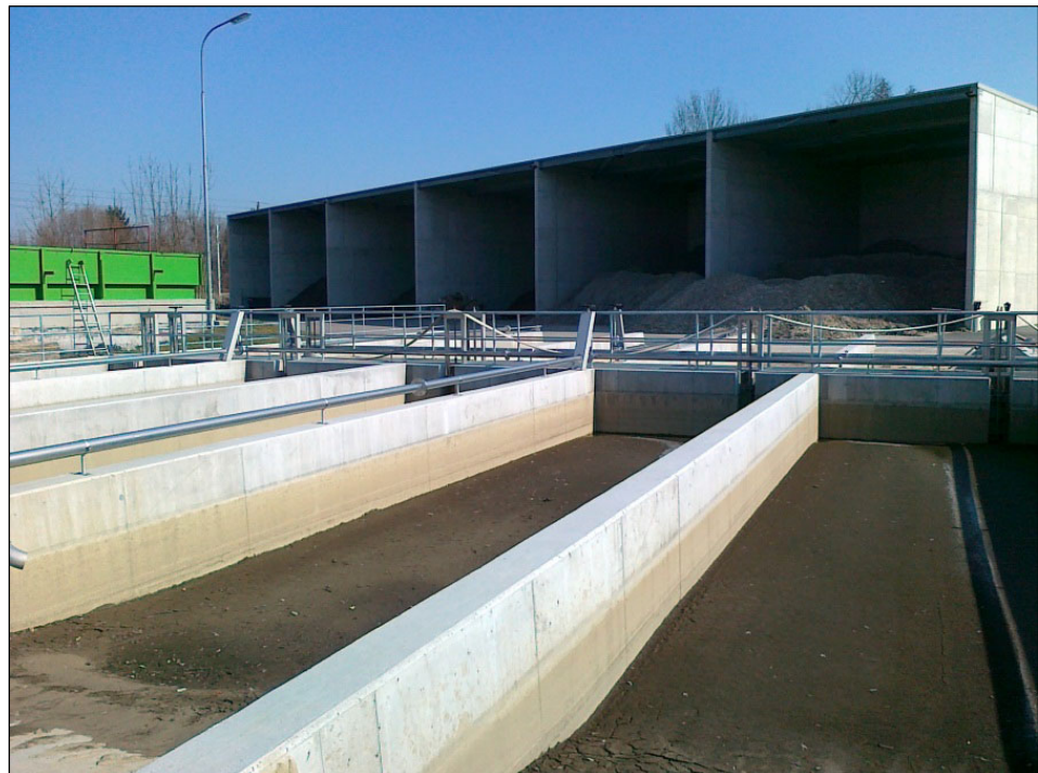
Abbildung 25: HAELA Abfallverwertung GmbH – im Hintergrund die Boxen für Material- zwischenlagerung, im Vordergrund die Schlammtrockenbecken (© HAELA).
