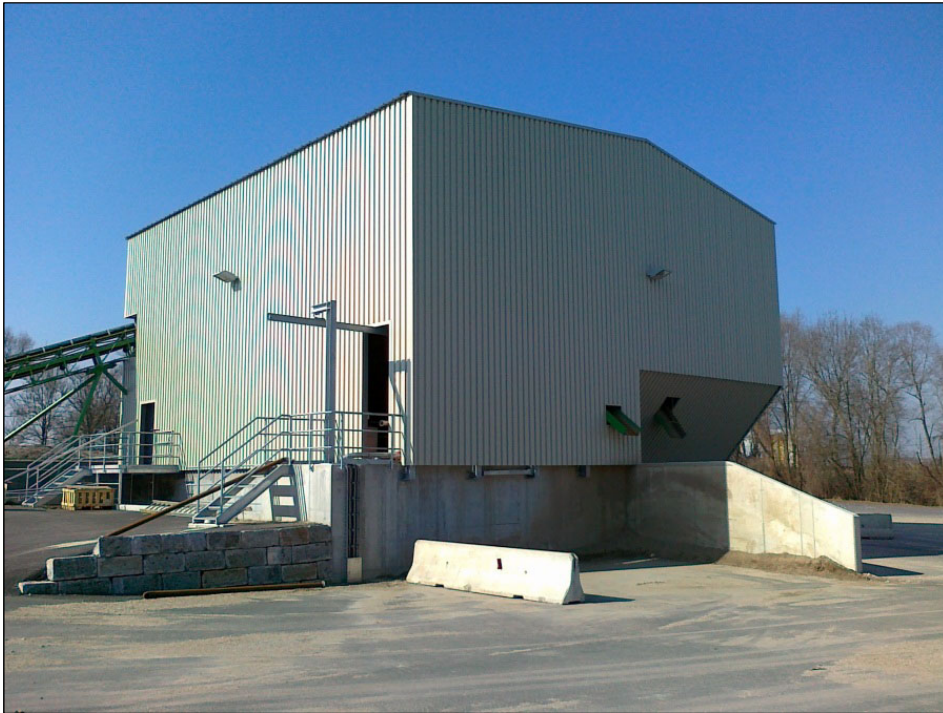
Abbildung 26: HAELA Abfallverwertung GmbH – fertiggestellte Anlage inklusive Einhausung der Wasch- und Siebanlage (© HAEA).
