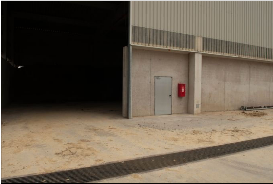
Abbildung 13: HAELA Abfallverwertung GmbH – Behandlungshalle mit Entwässerungsrigol am Vorplatz (© Umweltbundesamt).
