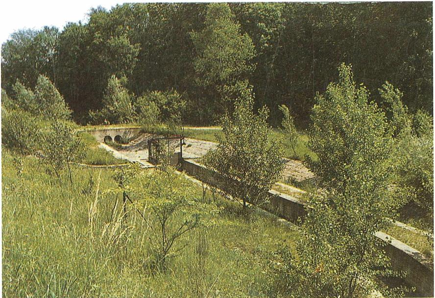
Ein Verteilerbauwerk im Stauraum Wallsee-Mitterkirchen leitet das Wasser aus dem Dotationsbauwerk in die Auwälder
