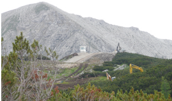
Abb. 4.2.1.2: Blick auf die Bautätigkeiten im Bereich des „oberen“ Schafkögelliftes und der neuen Piste im Sommer 2008.
