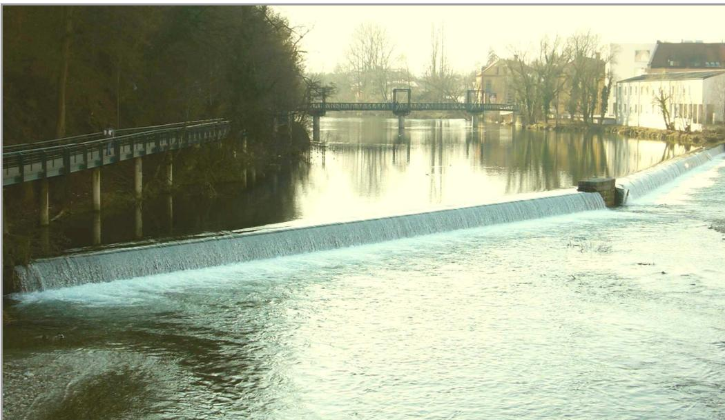
Abb. 4: Die Wehranlage am Standort 2 ist schräg angeordnet und etwa in der Mitte geknickt (im Hintergrund der Museumssteg)
