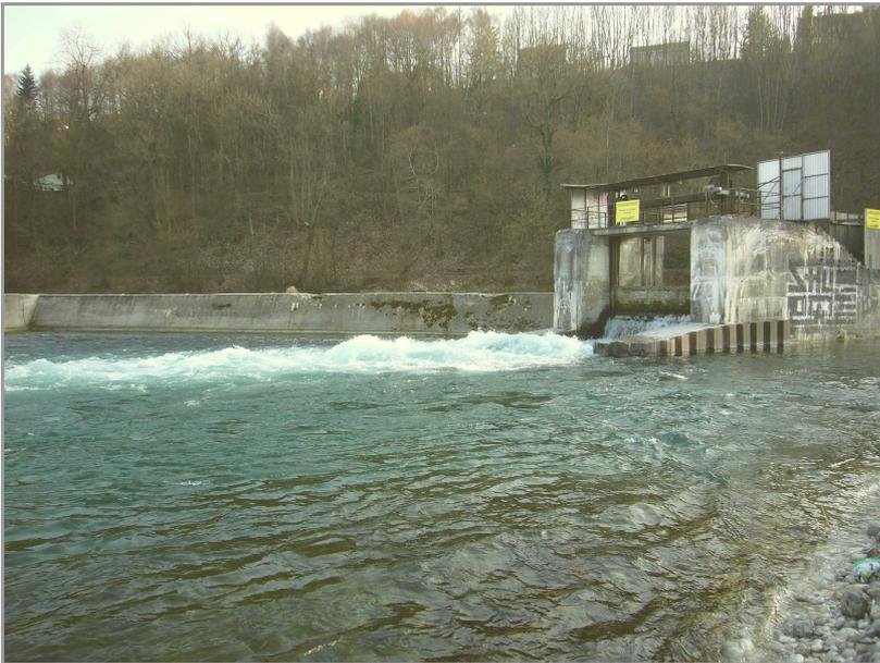
Abb. 6: In das Kugelfangwehr ist ein Bauwerk zur dosierten Geschiebeabgabe integriert.
