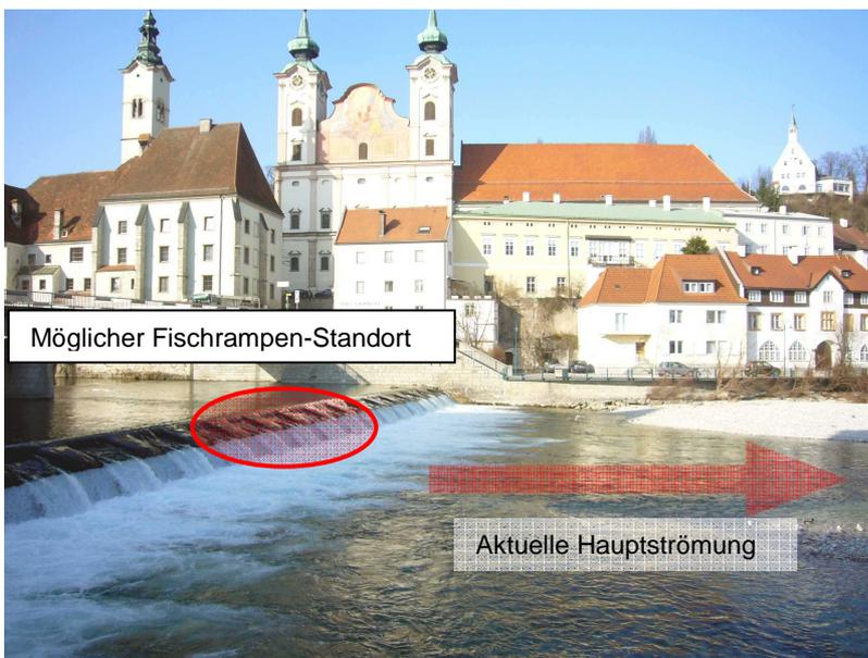
Abb. 3: Am Standort 1 ist die Herstellung einer Fischrampe eine kostengünstigere Alternative zum Totalumbau
