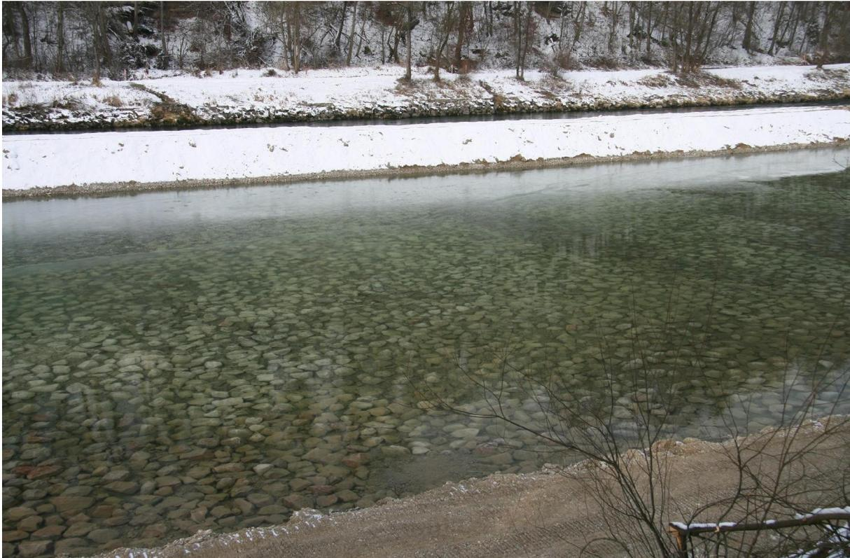
**Abbildung 20: offenes Deckwerk, Einbau bei Laufen (Schaufler, 2008)**
