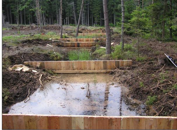
**Abb. 168:** Ostteil von Graben C einen Tag nach der Errichtung der Grabensperren (Juli 2004)
