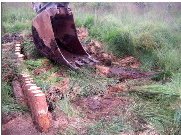
**Abb. 146:** Aufbringen von Vegetations soden auf die Torfhinterfüllung (Foto: H. Haubner, 03.08.2006)
