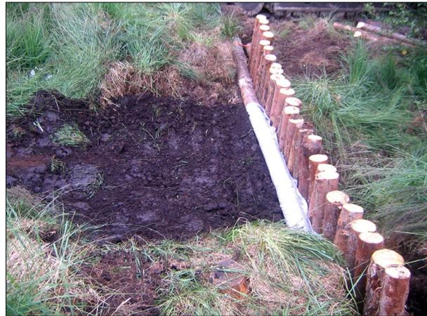
**Abb. 145:** Grabeneinstau mittels Torfwehre (Holz-pilotage, Drainagefließ, Torfhinterfüllung) im NSG Bumau (Foto: H. Haubner, 03.08.2006)
