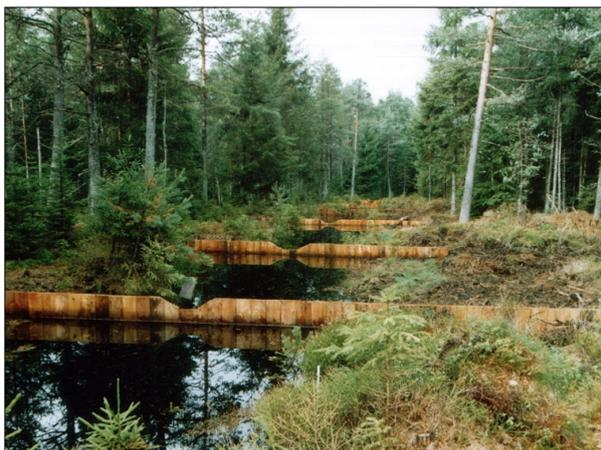
**Abb. 133:** Wirksamer Rückhalt des Wassers in den Staubecken zwischen den Sperren (September 2004)
