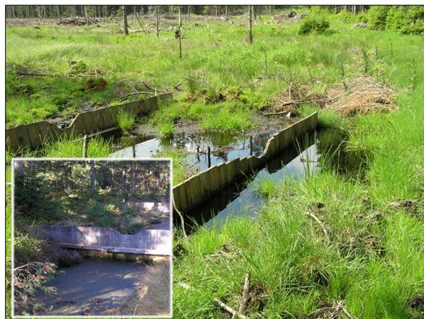
**Abb. 134:** Seitlich umspülte, reparaturbedürftige Sperre (16.06.2005). *Insert:* Absinken des Wasserspiegels nach Sperrenunterspülung (18.10.2006)
