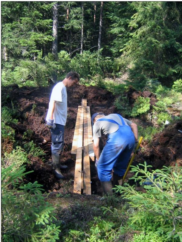
**Abb. 126:** Ausrichten der Kantholzkonstruktion als Stabilisierungsschiene für das Sperrenbauwerk (Foto: I. Ortner, 31.07.2004)
