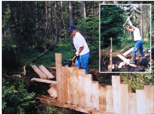
**Abb. 136:** Hineinschlagen der Pfosten mit einem schweren Vorschlaghammer (August 2004)
