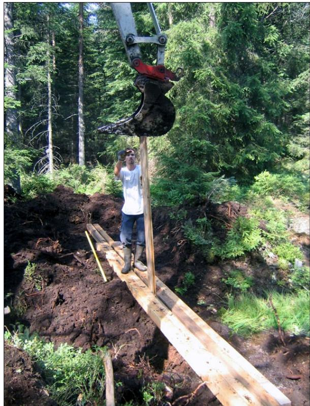
**Abb. 127:** Setzen des zentralen Leitpfostens in der Mitte der künftigen Sperre (Foto: I. Ortner, 31.07.2004)
