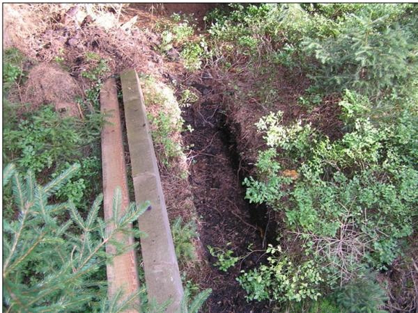
**Abb. 135:** Ein händisch ausgehobenes Sperrenbett sollte nur geringfügig breiter als die Kantholzkonstruktion sein (15.09.2005)
