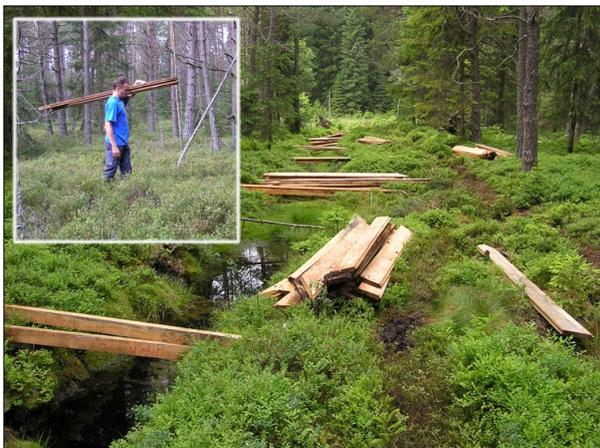
**Abb. 121:** Zwischenlagerung der Sperrenbauteile am Bestimmungsort. *Insert:* Transport der Bauteile im Moor (Juli 2004)
