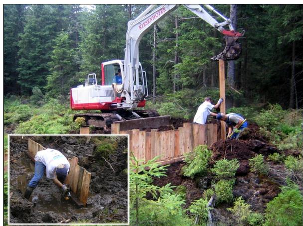
**Abb. 130:** Sperre kurz vor Fertigstellung (Foto: I. Ortner, 31.07.2004). *Insert:* Korrektur der Schraubverbindung mit dem Winkelschleifer
