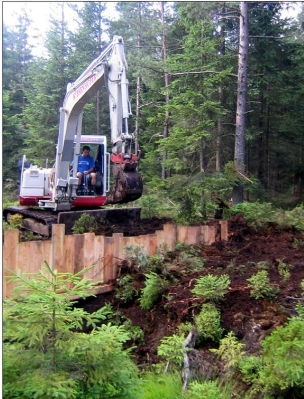
**Abb. 131:** Auffüllen des Sperrenbetts mit dem Aushubmaterial und Abdeckung der Oberfläche mit Vegetations soden (Foto: I. Ortner, 31.07.2004)
