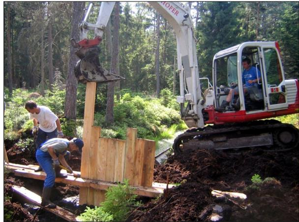
**Abb. 129:** Setzen der übrigen, einseitig zugespitzten Pfosten (Foto: I. Ortner, 31.07.2004)
