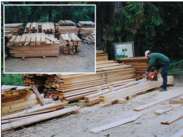
**Abb. 119:** Zuschneiden der Pfosten und Kanthölzer gemäß Ablängplan. *Insert:* Zwischenlagerung der fertigen Sperrenbauteile (April/Mai 2004)
