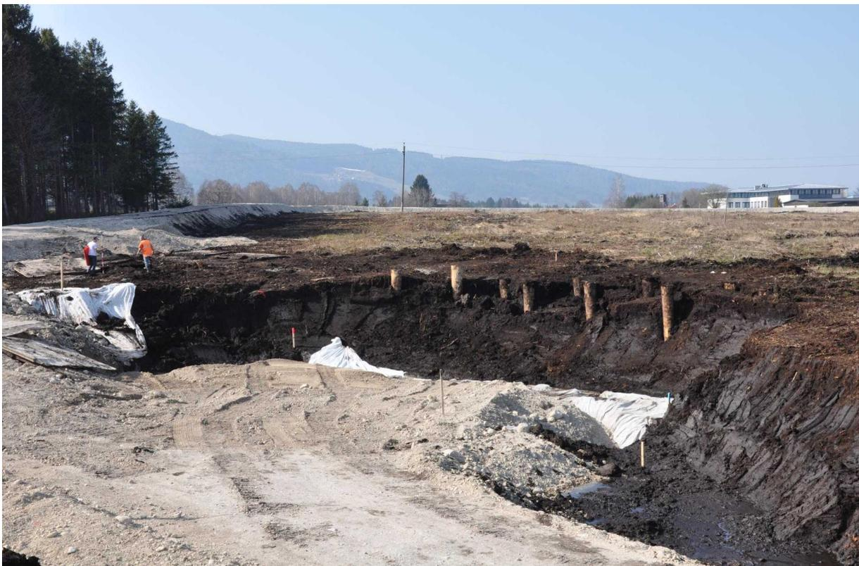
Ausheben der Baugrube nach der Winterpause im März 2012. Mächtige Torflager werden freigelegt.
