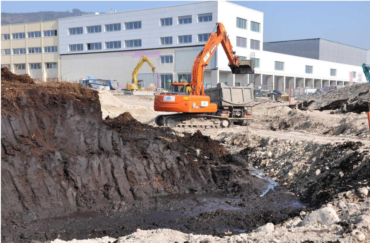
Ausheben der Baugrube nach der Winterpause im März 2012. Mehrere Meter mächtige Torfschichten sind abzugraben, um die Bauland-"Eignung" herzustellen.
