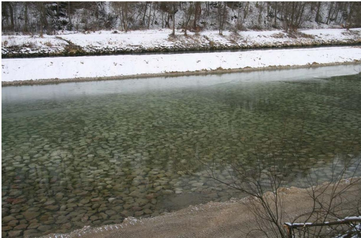
*Abbildung 25: offenes Deckwerk, Einbau bei Laufen (Schaufler, 2008)*
