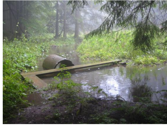
Abb. 13 / Abb. 14 Künstliche Staustufe mit Brettersteig und Betonrohr
