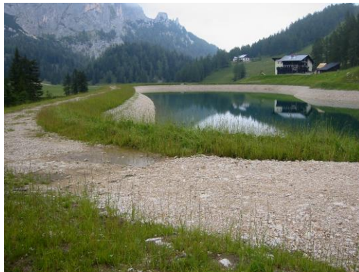
Abb. 161 Blick auf den neuen Wasserspeicher, dahinter das Linzerhaus
