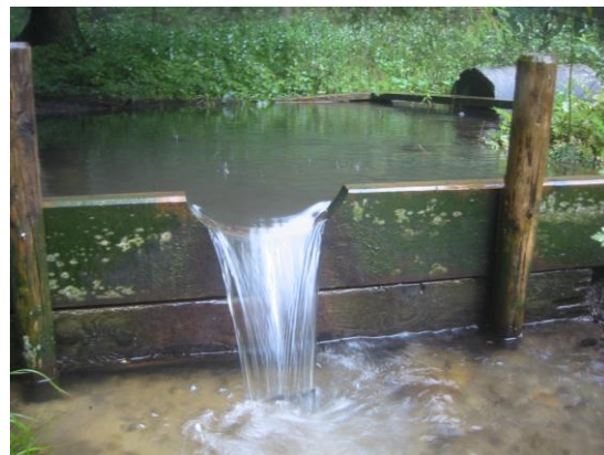
Abb. 15 / Abb. 16 Künstliche Staustufe mit Überlauf
