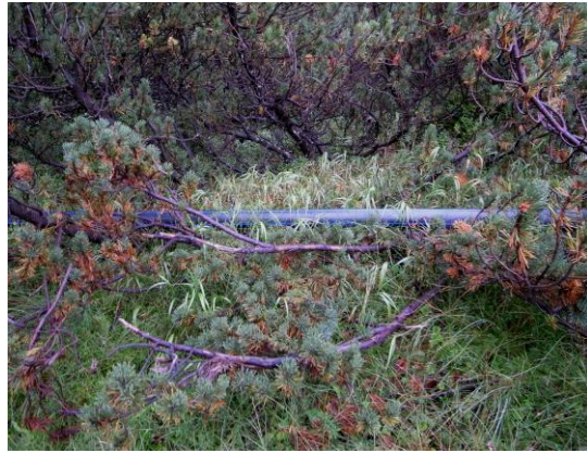
Abb. 159 / Abb. 160 Ein Gummischlauch mit etwa 20 cm Durchmesser wurde oberflächlich durch das Moor verlegt (2008)
