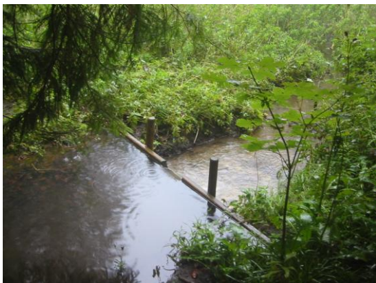
Abb. 15 / Abb. 16 Künstliche Staustufe mit Überlauf
