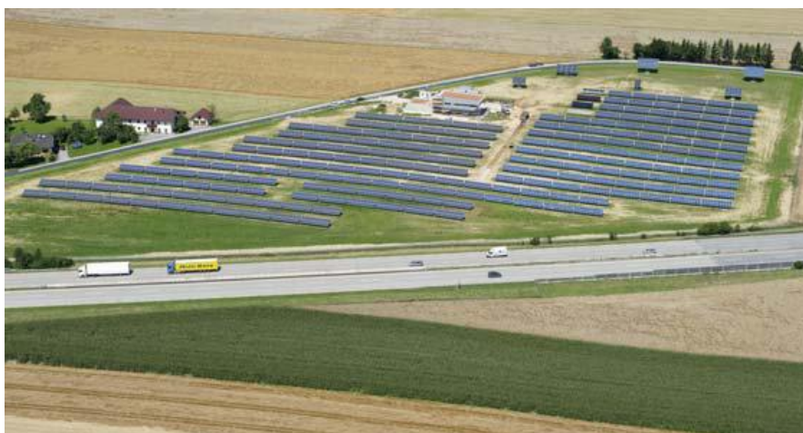
Abbildung 1: PV-Kraftwerk Eberstalzell (Oö); 1 MW peak , gute Sichtbarkeit an der A1, Forschungsanlage, Freiflächenanlage (6 ha), Inbetriebnahme: 2010 3
