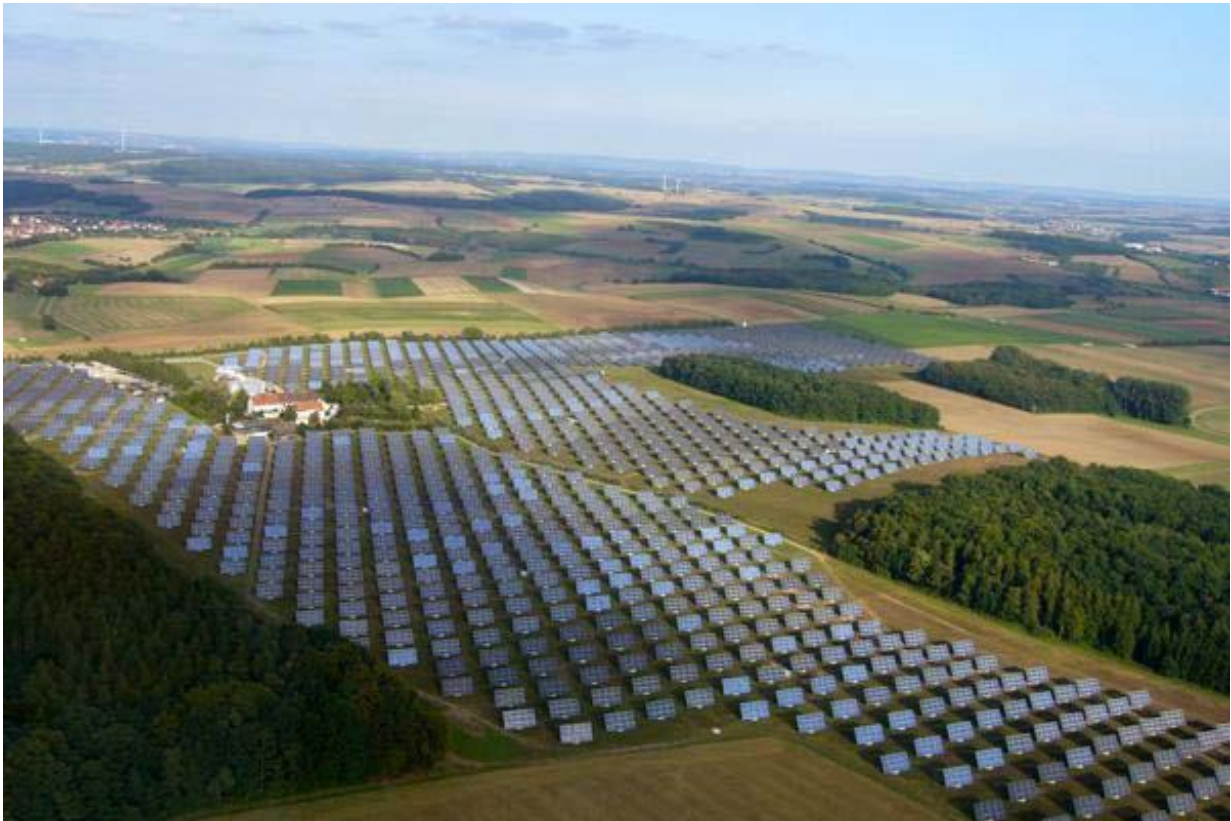
Abbildung 4: Solarpark Gut Erlasee (Deutschland); 12 MWp, Investitionsvolumen ca. € 70 Mio., 77 Hektar, 1.408 SOLON-Mover, jährliche Stromproduktion 14.000 MWh; Solarstrom für rund 3.500 Haushalte ( www.solarserver.de )
