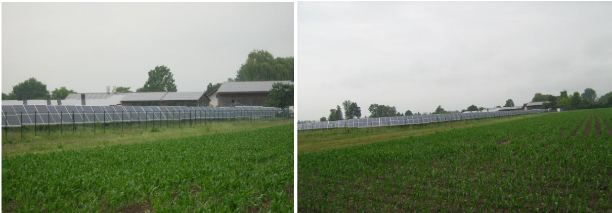
Abbildung 5: PV-Anlage im "Hofnahbereich" – ... aber: wo hört der auf?
