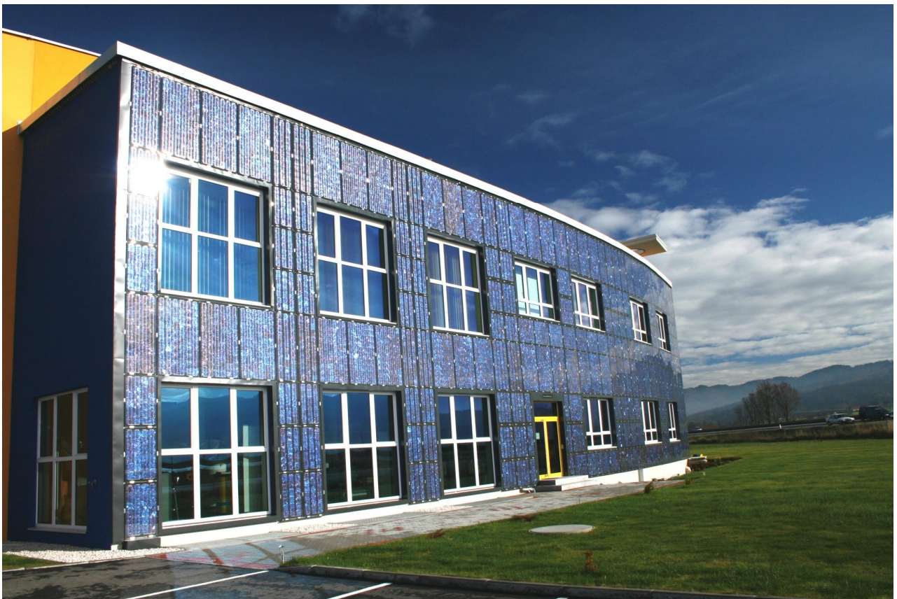
PV-Fassade eines Betriebsgebäudes in Schörfling am Attersee
