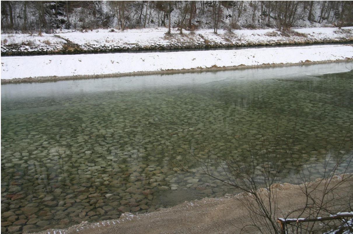
Abbildung 20: offenes Deckwerk, Einbau bei Laufen (Schaufler, 2008)
