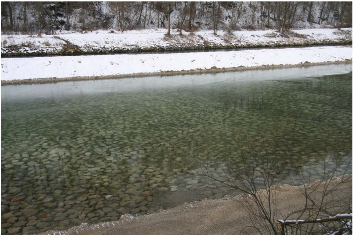
Abbildung 25: offenes Deckwerk, Einbau bei Laufen (Schaufler, 2008)
