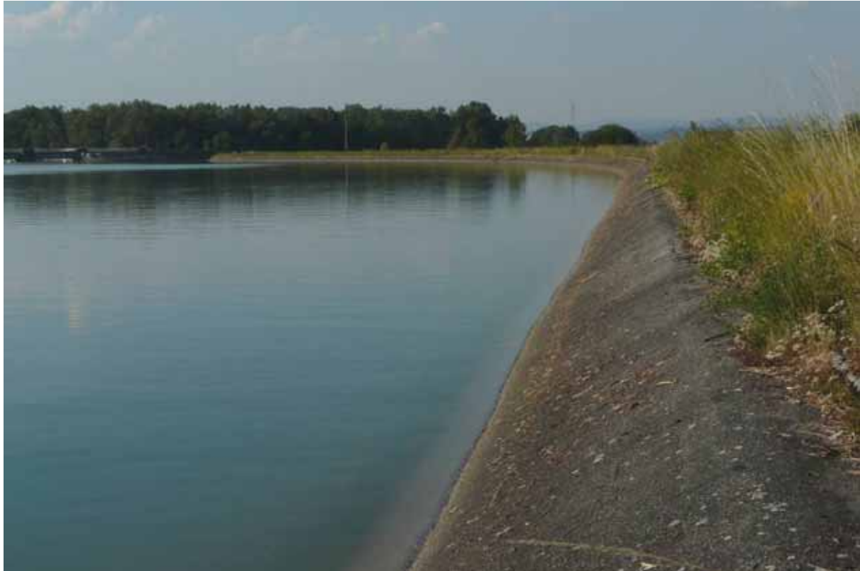
Foto A 83: Besser als auf Foto A 81 erkennt man die naturferne Gestaltung des Uferdamms. Wo die Ufer der Enns höher als das hinterland liegen, sind sie an der Unteren Enns überwiegend so ausgeführt. Nur an kleineren Abschnitten hat man die Betonplatten beschüttet und Uferbewuchs ermöglicht. Vgl. auch Foto A 63.
