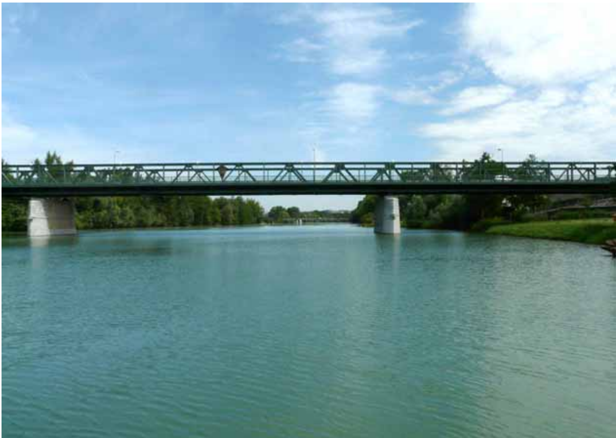
Foto A 102: Blick von einem rechtsufrigen Buhnsporn flussab gegen die Brücke Enns-Ennsdorf. Staubereich des Hilfswehrs Enns.
