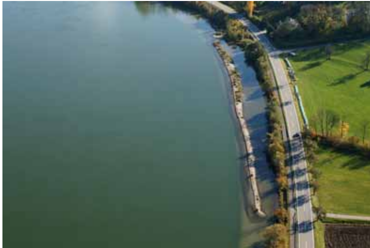
Abbildung 136: Beispiel für eine Strukturierungsmaßnahme in einem Stauraum: Vorschüttung einer schmalen Kiesbank bei Kasten (Stau KW Jochenstein an der Donau; siehe ZAUNER & RATSCHAN, 2004).
