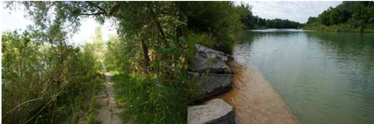
Abbildung 156: Links: Damm im Bereich der Rampe. Rechts: Betonierte Berme zur Sicherung des Böschungsfußes.
