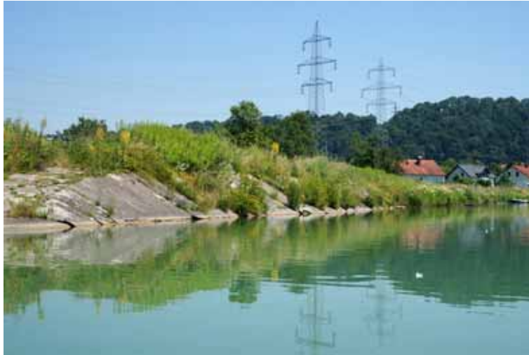
Abbildung 112: Ökologisch verbesserungswürdiges Ufer im Bereich der Maßnahme C_11.
