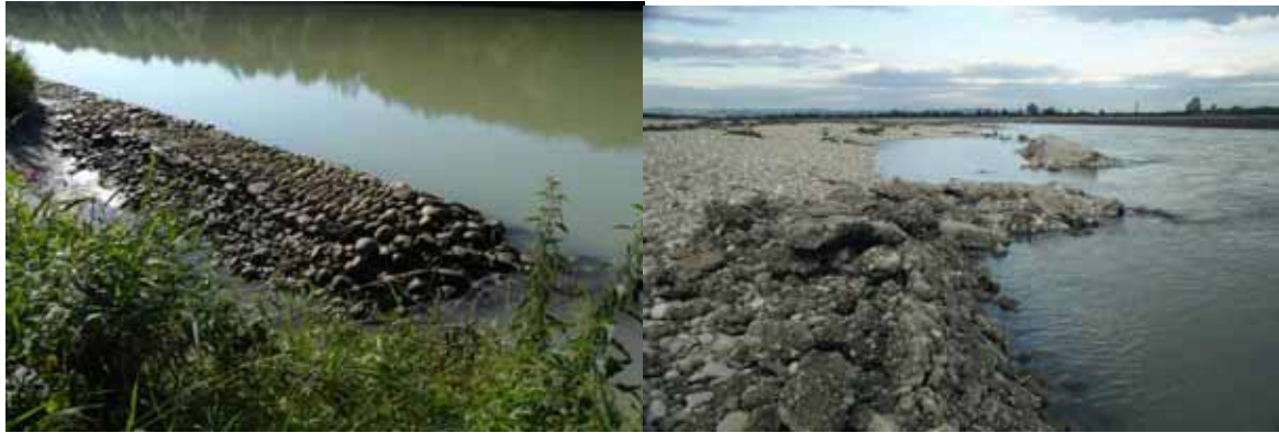
Abbildung 40: Die Regulierungsbauten aus dem 19. Jahrhundert. Links: aus Flussschotter gefertigte Dämme finden sich fast überall entlang der Unteren Enns. (Hier: Stauraum Mühlradung bei abgesenktem Stauspiegel. Die Dammkronen liegen heute sonst ca. 1 Meter unter Wasser). Rechts: Abgesenkter Stau im Jahr 2002: Weit draußen tauchen alte Regulierungsbauten auf.
