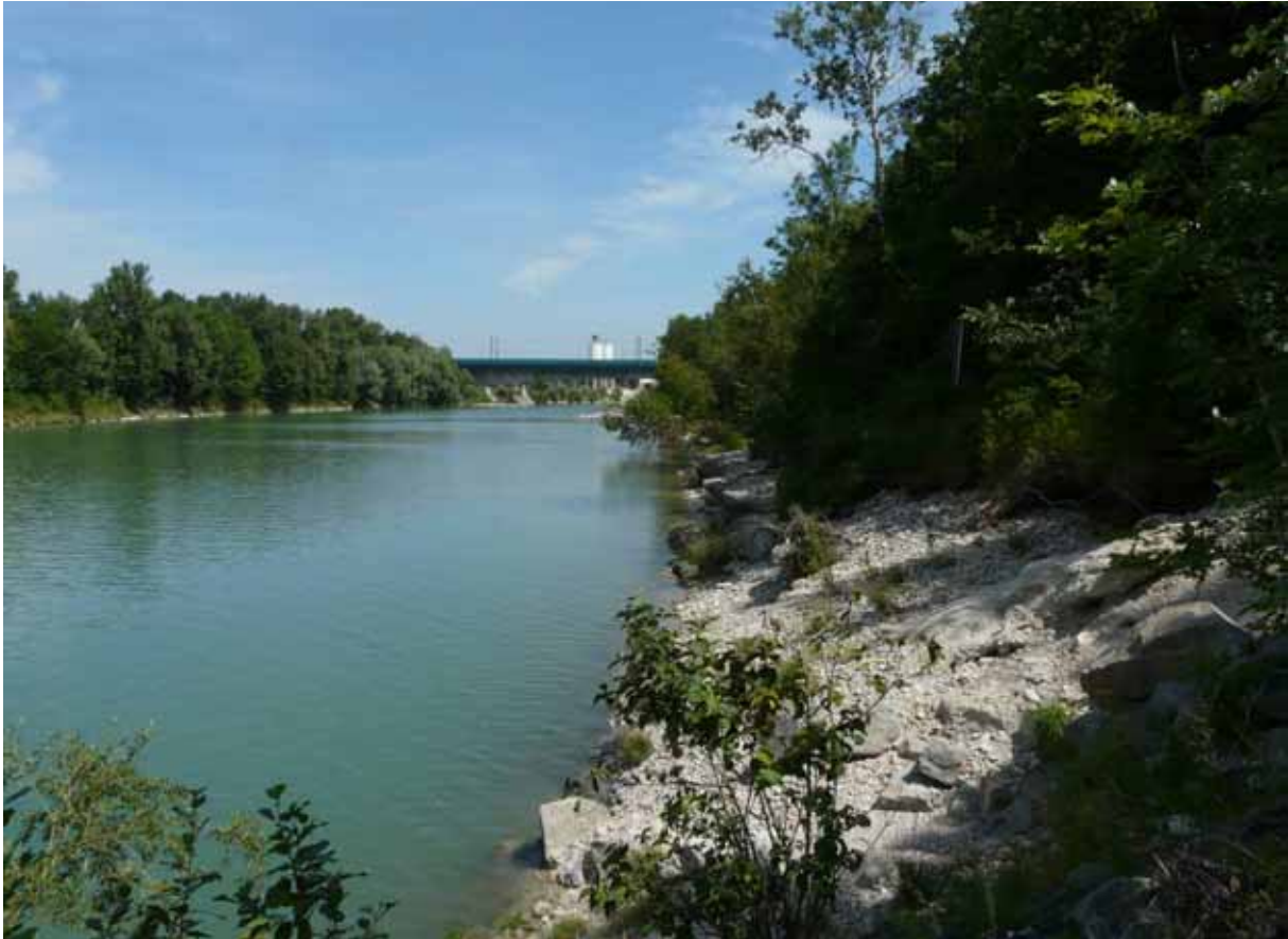
Foto A 105: Das hohe und steile rechte Ufer unterhalb des Hilfswehrs. Im Hintergrund die Brücke der neuen Bundesstraße 1.
