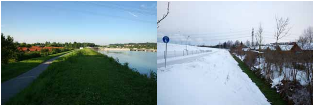
Abbildung 113: Links: Blick über den Damm im Oberwasser. Rechts: Qualmgang zwischen Damm und Kleingartensiedlung.
