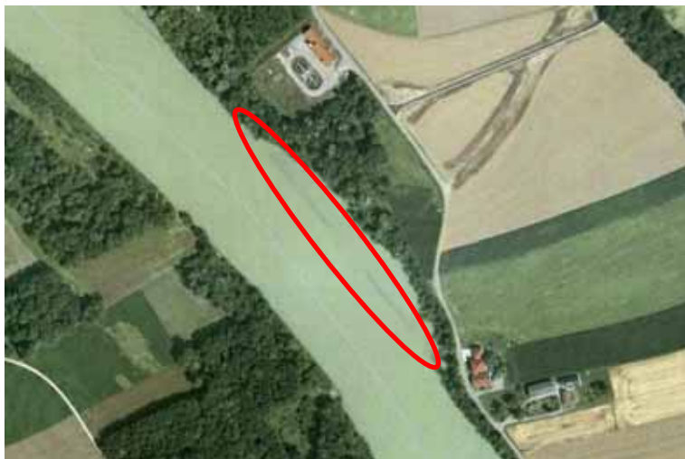
Abbildung 127: Lage des überstauten Leitwerks.
