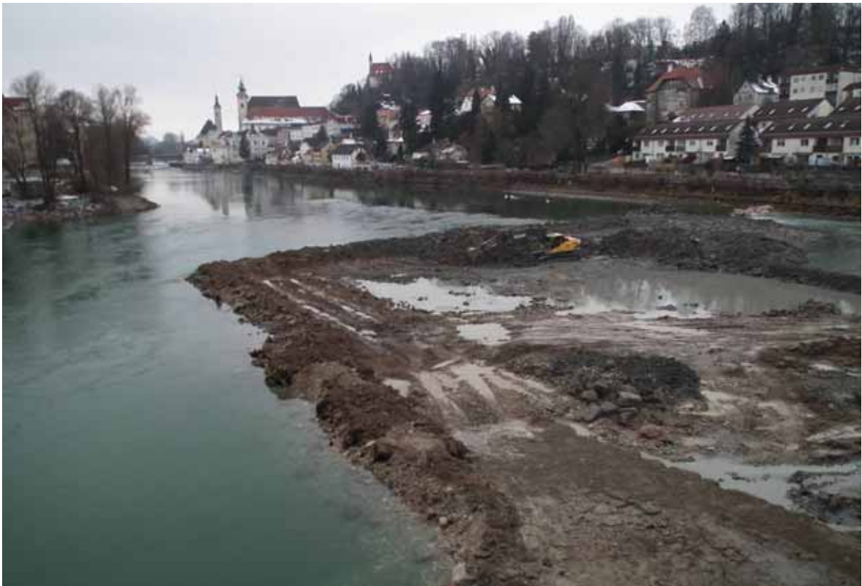
Foto A 20: Wo sich der Fluss verbreitert, begann bis Dez.2010 ein Längsdamm, der zur Spitze der Rederinsel verlief. Die Verbreiterung des Flusses in diesem Bereich gibt Spielraum für Renaturierungsmaßnahmen.
