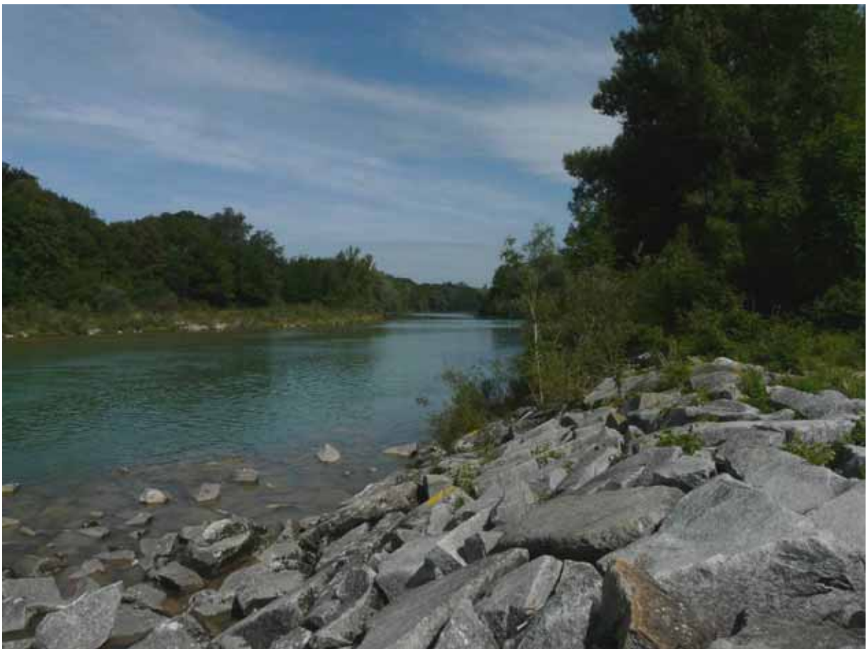
Foto A 96: Unterwasser der ersten Rampe.
