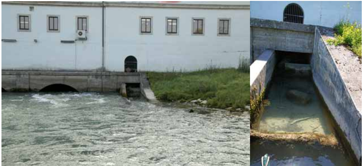
Abbildung 115: Blick auf den Einstieg in den bestehenden, alten Beckenpass (außer Betrieb).
