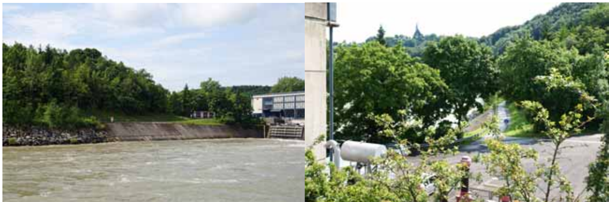
Abbildung 69: Unterwasser KW Garsten (li) rechtsufrig und Kraftwerksgelände (re).
