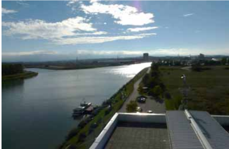
Abbildung 171: Blick über den Ennshafen flussaufwärts. Am linken Bildteil beginnt der Bereich der vorgeschlagenen Maßnahme E27. Auch südwestlich des abzweigenden Hafenbeckens ist eine Bepflanzung der Ufer teilweise noch möglich. Die Zerschneidungswirkung des Ennshafens bezüglich der Naturräume an den Ufern von Donau und Enns soll reduziert werden.
