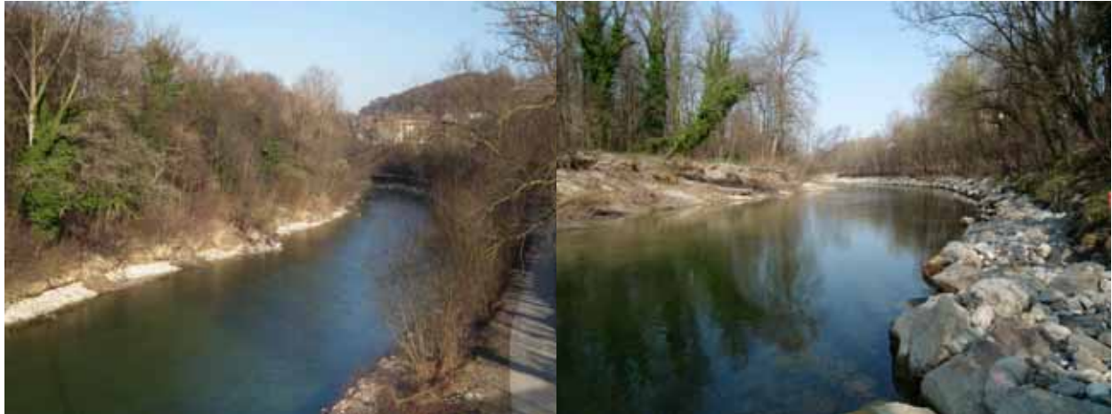
Abbildung 82: Links: Blick auf den Nebenarm bei bereits abgesenktem Wasserstand. 8.3.2011; Rechts: Blick bei Niederwasser im umgesetzten Zustand.
