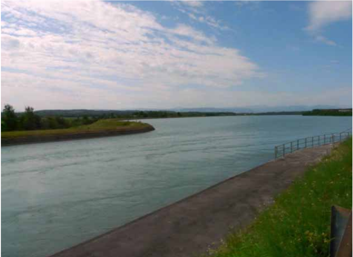
Foto A 85: Beginn des Ennskanals, der am KW Thaling aus dem alten Flussbett abgezweigt wird.
