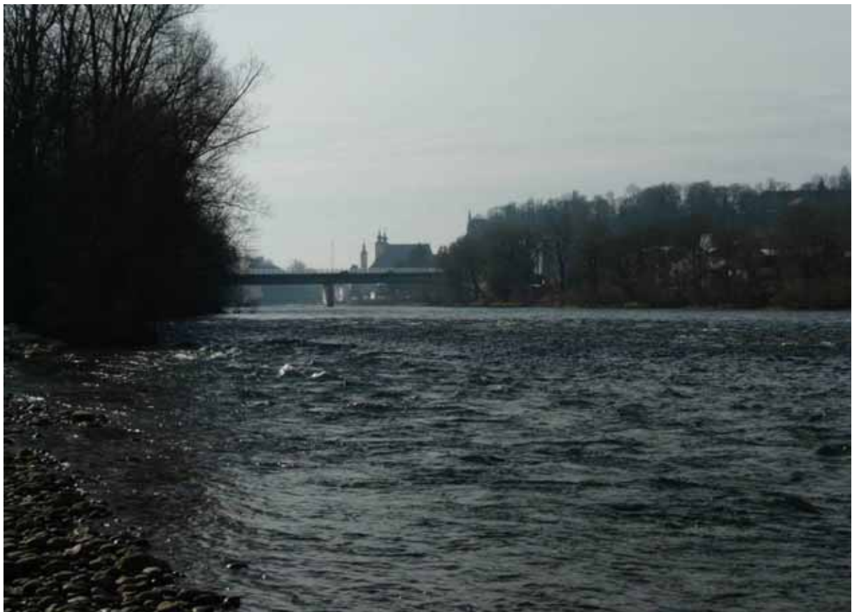
Foto 24: Wie Foto 22, aber vom unteren Ende der Rederinsel flussaufwärts betrachtet. Im Bild Rederbrücke und im Hintergrund Michaelerkerche bei Zwischenbrücken.
