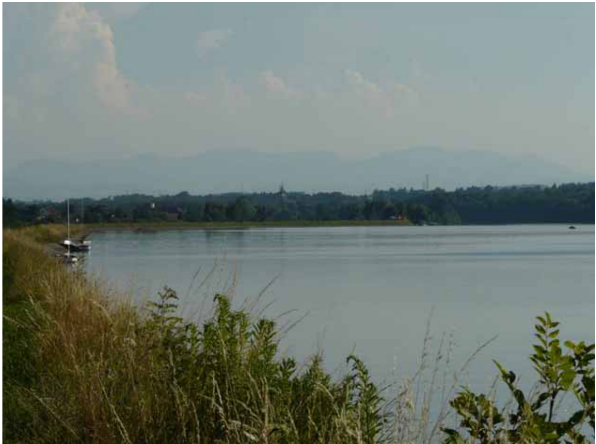
Foto A 81: Blick vom rechten Ufer knapp oberhalb des KW Thaling über den breiten Stausee gegen Kronstorf.
