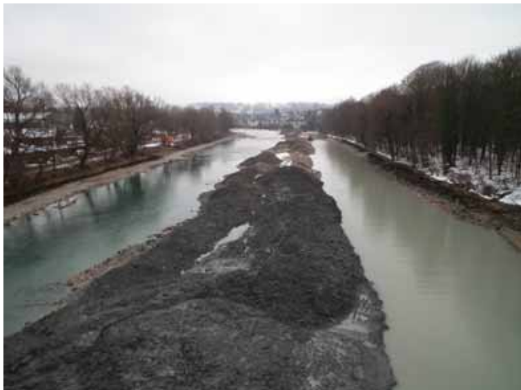
Abbildung 67: Blick stromab der Rederinsel; Baumaßnahmen im Jänner 2011.
