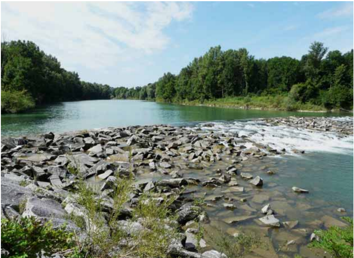
Foto A 95: Die obere Rampe.
