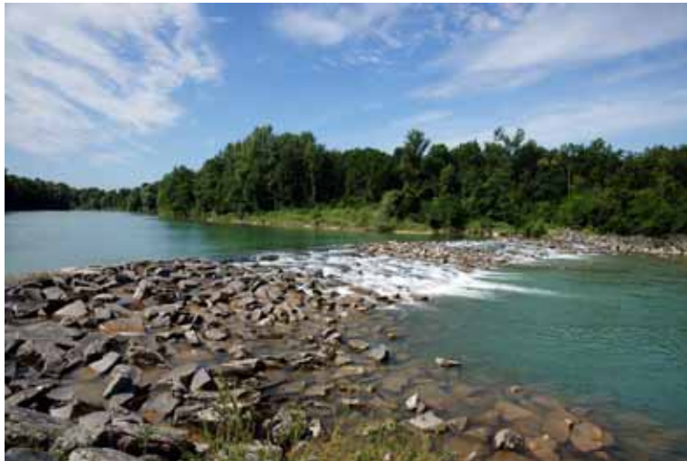
Abbildung 152: Blick stromaufwärts auf die obere Rampe.
