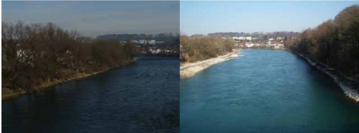
Abbildung 68: Links: Zustand im Februar 2010. Rechts: Ruhiger Abfluss der Enns unterhalb der Rederbrücke bei weit fortgeschrittenem Hochwasserschutz (die Kräuselung der Wasseroberfläche beruht auf herrschendem Ostwind).
