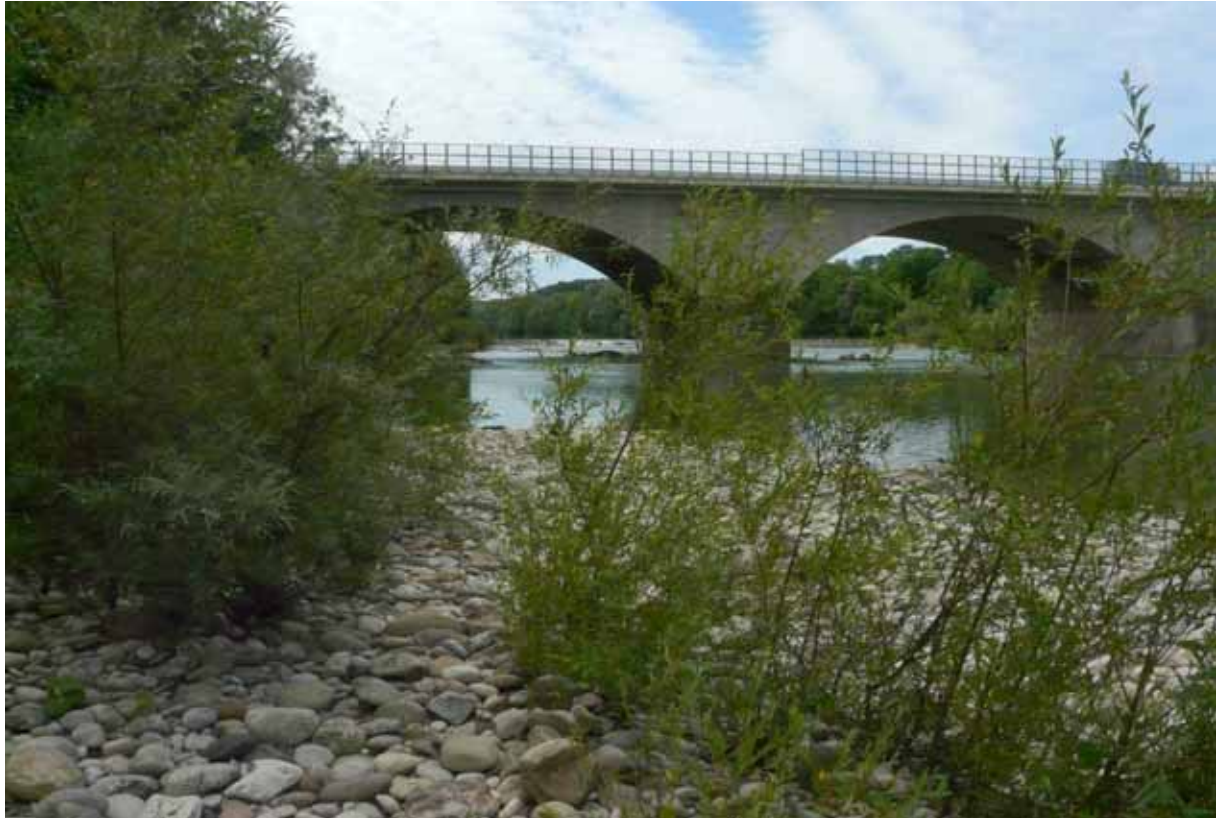
Foto A 99: Vom rechten Ufer unterhalb der Autobahnbrücke flussaufwärts. Pionierweidengebüsche.
