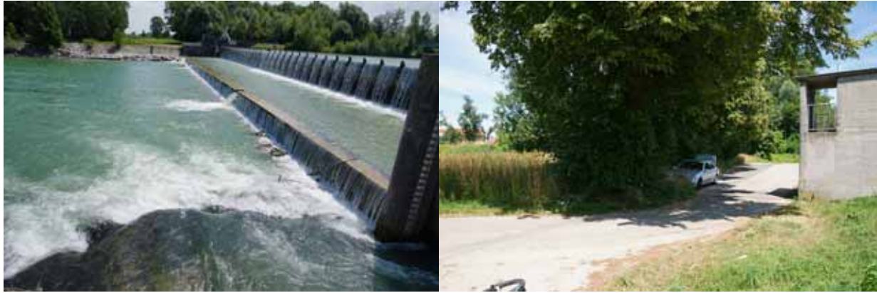
Abbildung 166: Links: Ausströmbereich der Turbine. Rechts: Linksufriges Vorland auf Höhe Hilfswehr.
