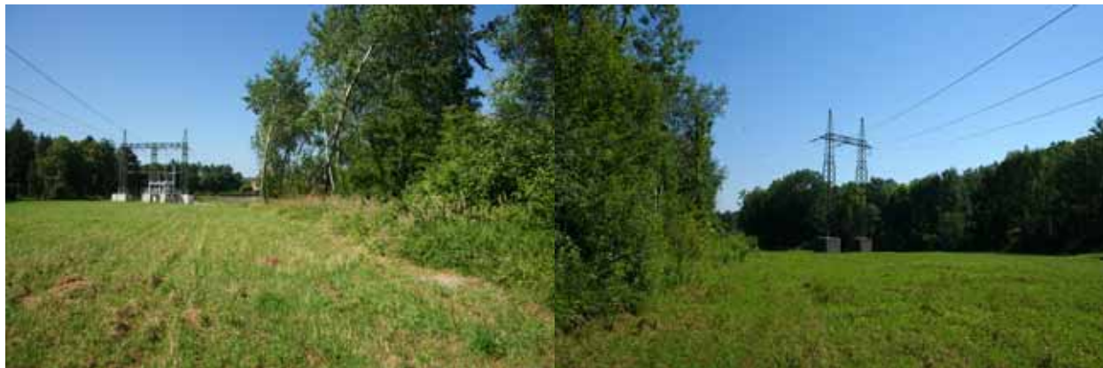
Abbildung 103: Vorlandfläche; Links: Blick stromauf; Rechts: Blick stromab.
