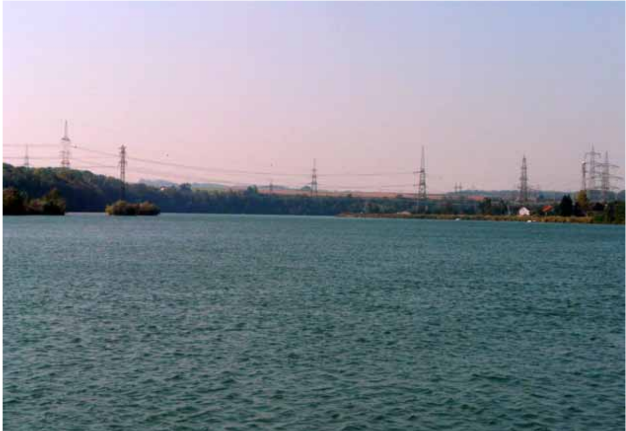
Foto A 63: Stausee Mühlradling. Am linken Bildrand ist erkennbar, dass das Ufer hier zurückspringt. Ein flacher Sedimentationsbereich ist ausgebildet. Zwei kleine Inseln sind vorgelagert. Der mit Betonplatten belegte Damm des rechten Ufers weist nur teilweise eine Beschüttung mit Bewuchs auf.
