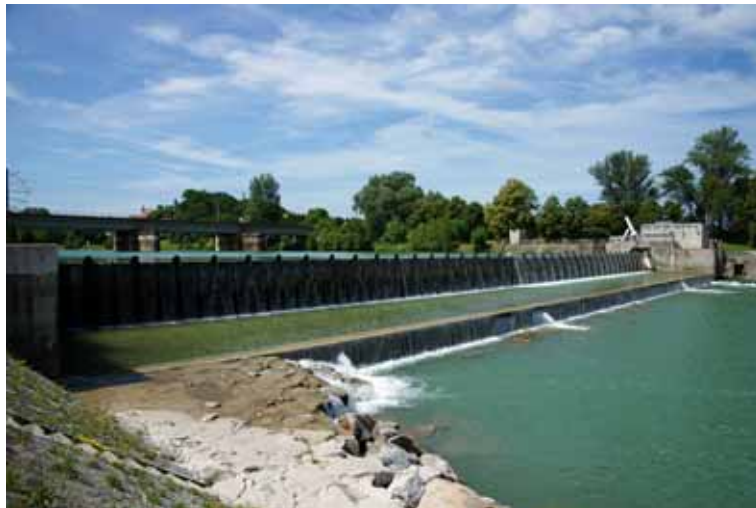
Abbildung 164: Blick auf den Einstiegsbereich.
