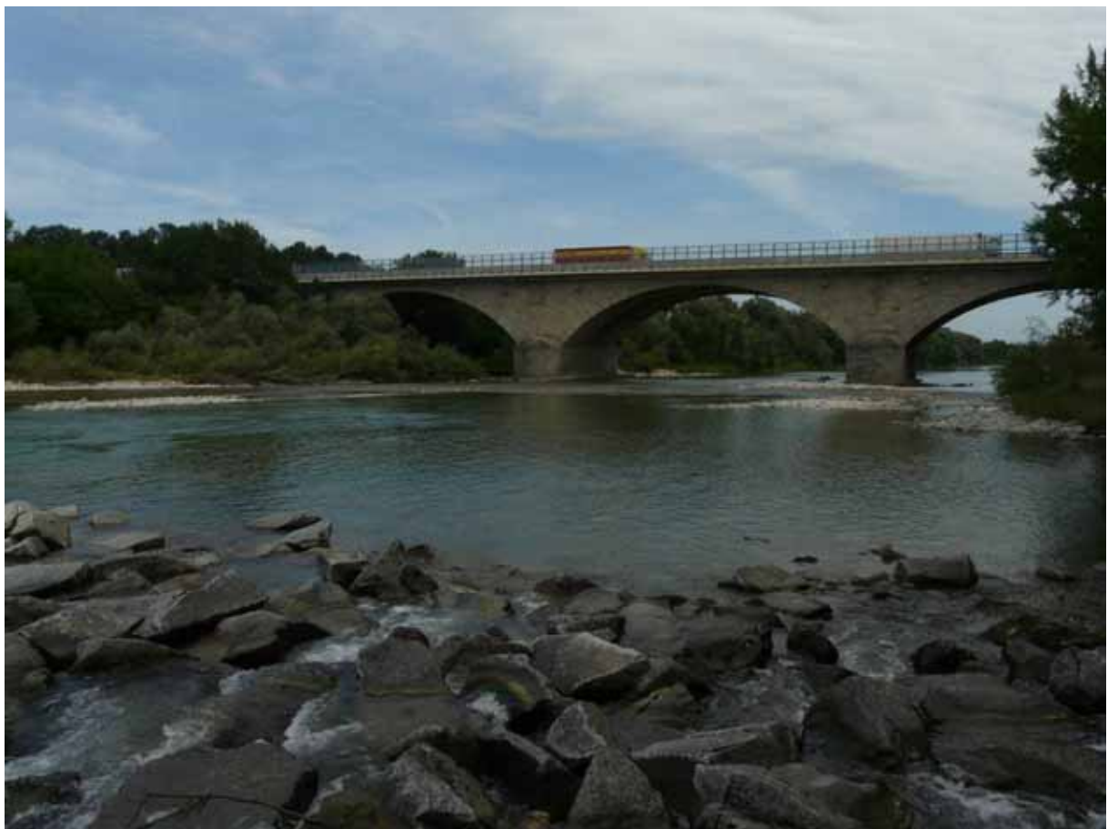
Foto A 98: Bei der zweiten Rampe, Blick flussabwärts. Autobahnbrücke. Wertvolle, dynamische Aubiotope.
