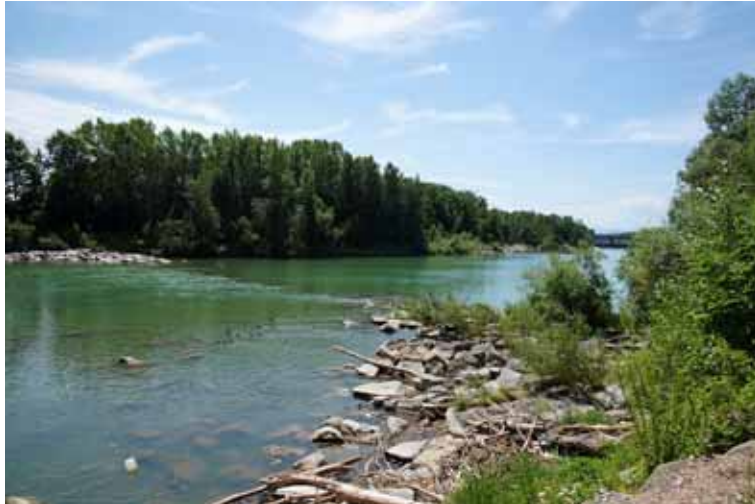
Abbildung 170: Schwelle stromauf der neuen Bundesstraßenbrücke
