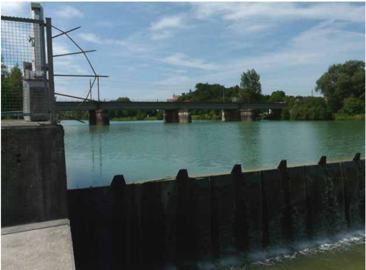
Foto A 104: Blick vom rechten Ufer am Hilfswehr Enns flussaufwärts. Hinter der Eisenbahnbrücke: Schloss Ennseck.
