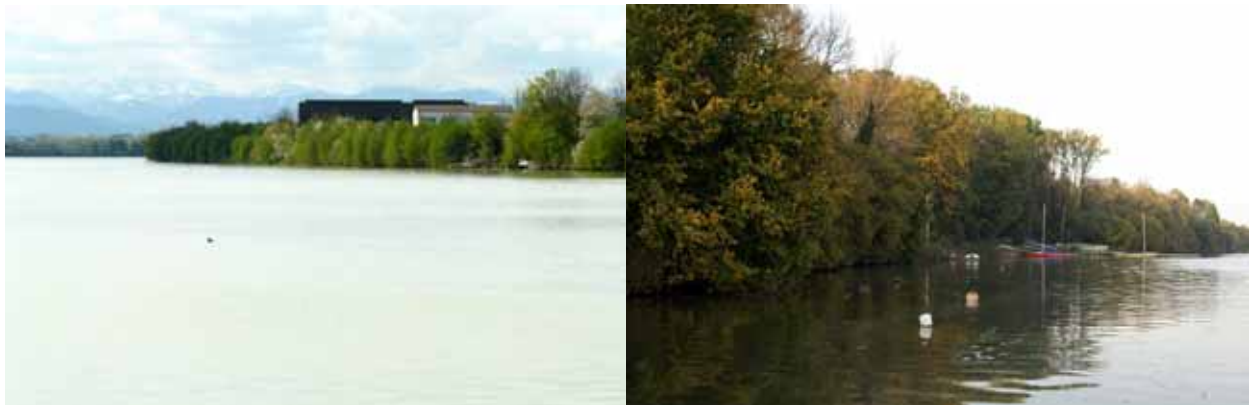
Abbildung 135: Links: Niederterrassenböschung am linken Ufer : Steiler Abfall, Mangel an Strukturen an der Wasserlinie; Rechts: Ufer im Bereich eines Segelclubs.
