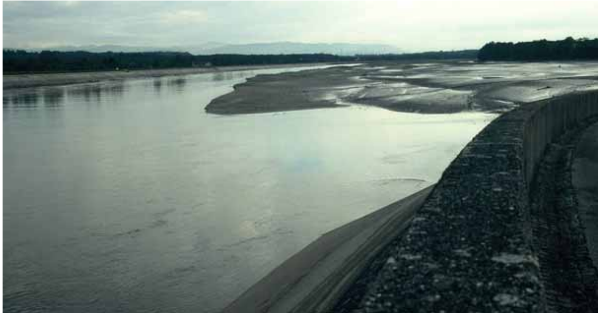
Abbildung 33: Mächtige Sedimentbänke treten oberhalb des Damms zum KW Thaling zu Tage (Spiegelabsenkung im Rahmen einer Revision im Jahr 2002).
