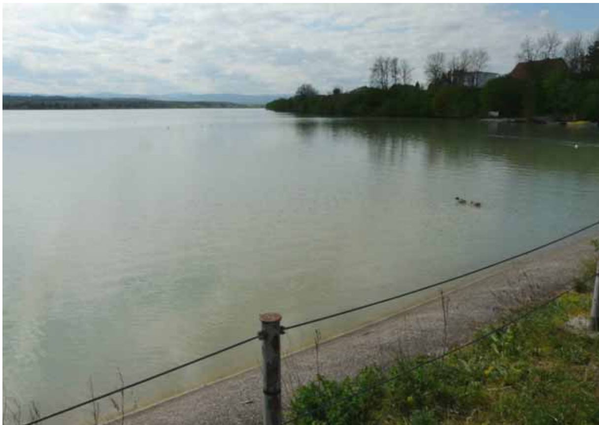
Foto A 84: Das eigentliche Wehrbauwerk des ausleitungskraftwerks Tahling erreicht man vom linken Ufer über einen ca. 400 m langen Damm. Blick über den Stausee flussaufwärts.
