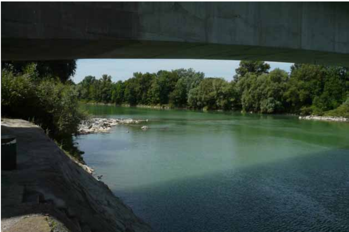
Foto A 106: Unter der Brücke der Bundesstraße 1, Blick flussaufwärts. Bei den Bühnenspornen an beiden Ufern liegt ein querwerk im Fluss. Hier endet das Gefälle der Enns gegen die Donau bzw. den Rückstau des Kraftwerks Wallsee.
