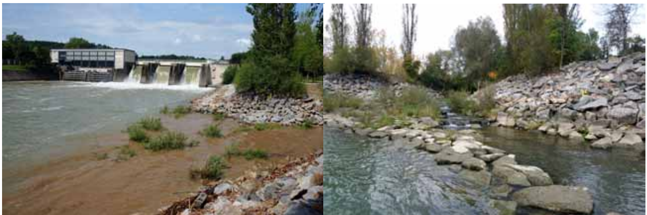
Abbildung 71: Situation im Unterwasser KW Garsten und Mündung des Garstener Bachs bei kleinem Hochwasser (links) sowie bei Niederwasser (rechts).
