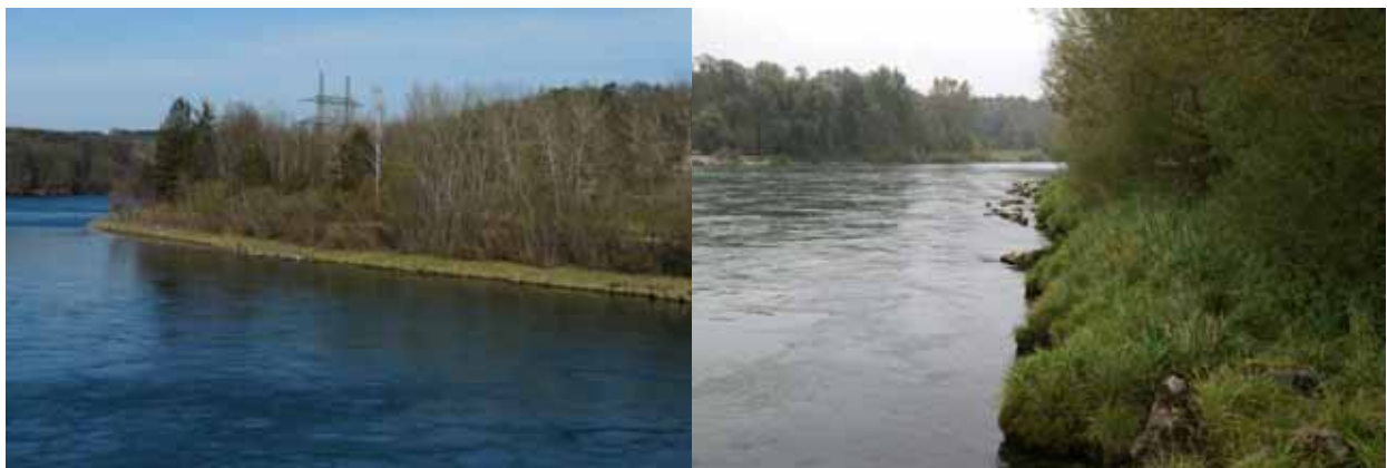
Abbildung 102: Blick auf das rechte Ufer im Maßnahmenbereich.
