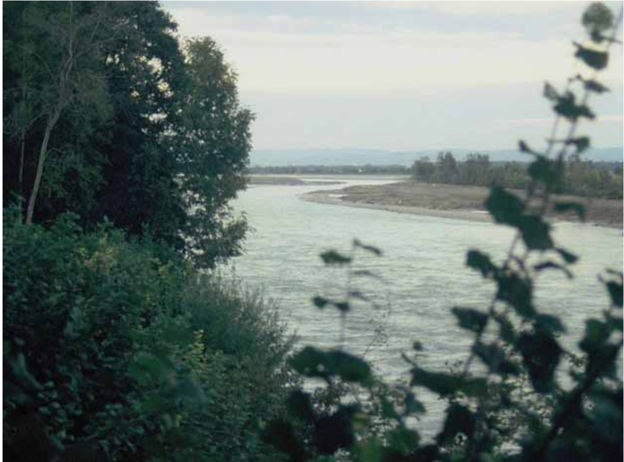
Foto A 75: Bei der Kraftwerksrevision im Jahr 2002 von der linksufrigen Niederterrasse bei km 11.100 flussabwärts.
