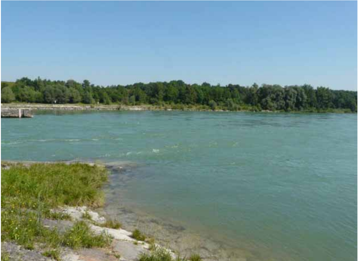
Foto A 55: Direkt unterhalb des KW Staning, Blick vom rechten zum linken Ufer.
