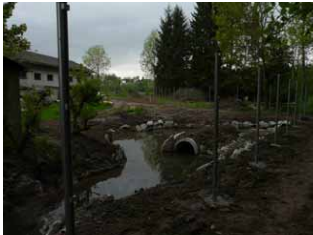
Abbildung 125: Privatgartenanlage am Lahnbach mit „Gewässerrückbau“.
