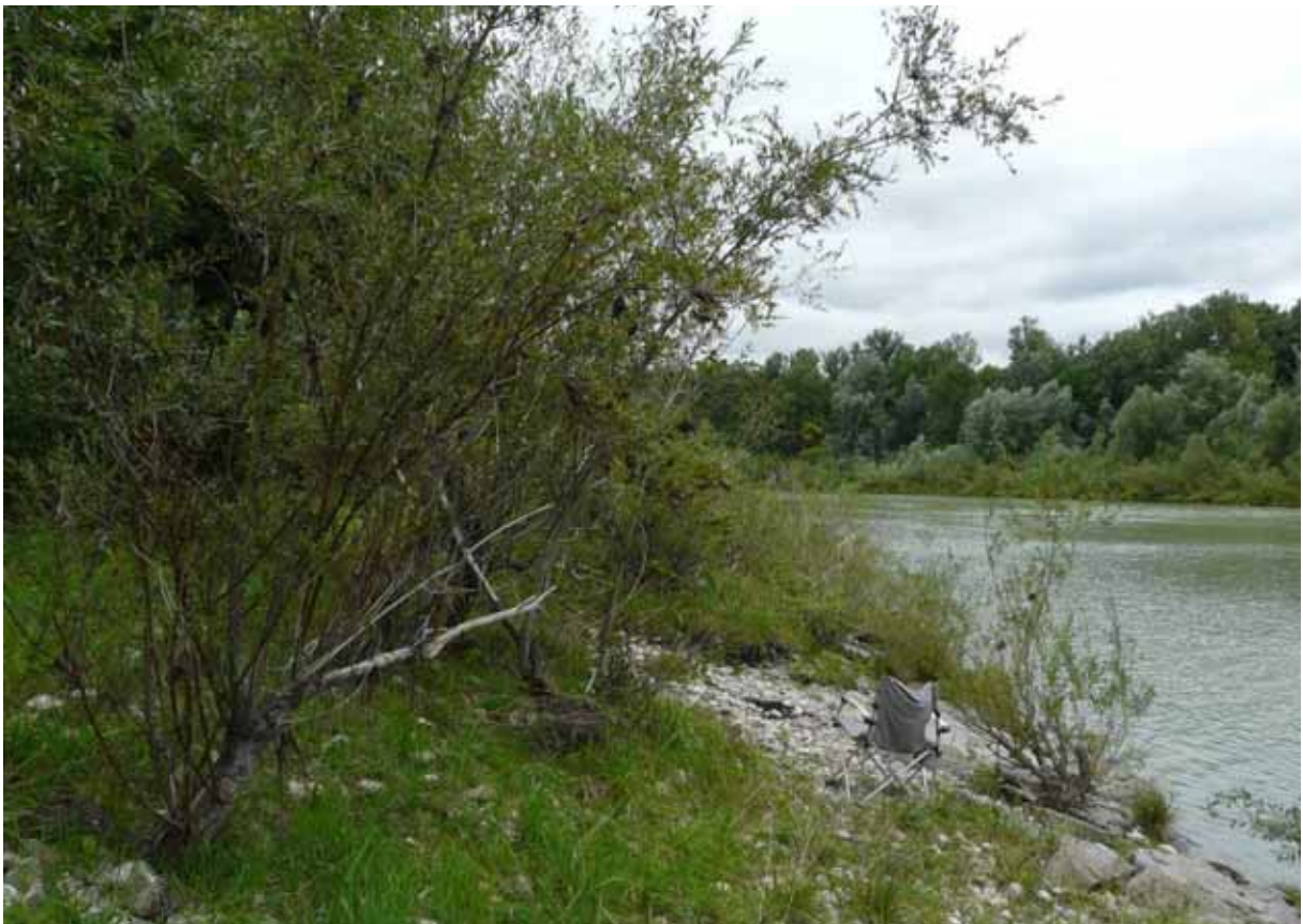
Foto A 94: Linkes Ufer unterhalb der ersten Rampe (km 6.600), Blick flussab. Der Schotter zeigt die Wirkung der Hochwässer. Der Rückstau der zweiten Rampe reicht bis hier her.
