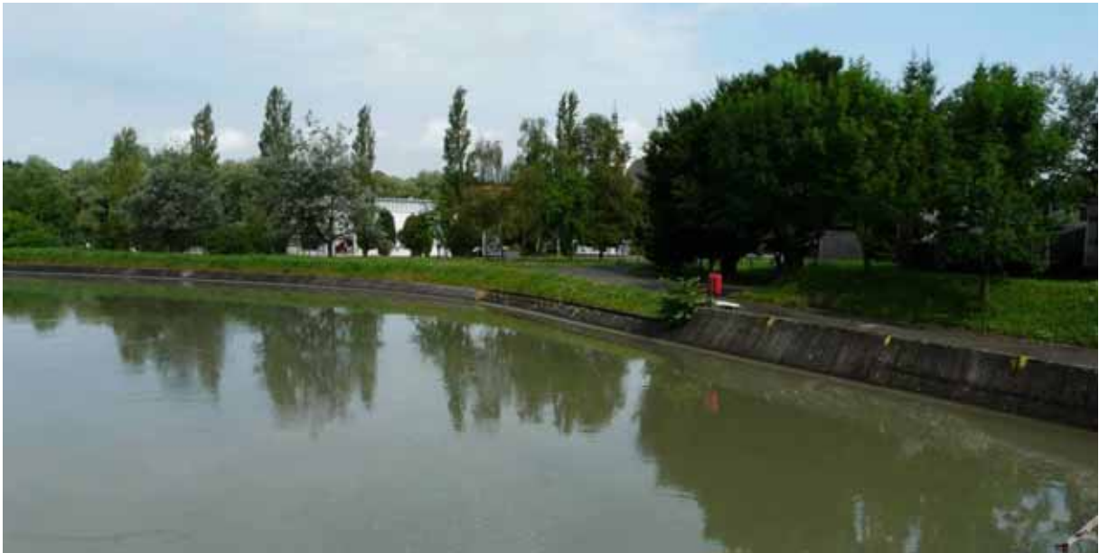
Foto A1: Oberwasser KW Garsten
