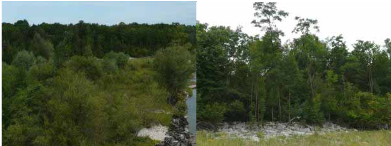
Abbildung 144: Linkes Ufer unterhalb des KW Thaling: Der Blockwurf am Ufer (links) soll entfernt werden, ebenso die Sicherung der etwa 100 m dahinter gelegenen Böschung (rechts).
