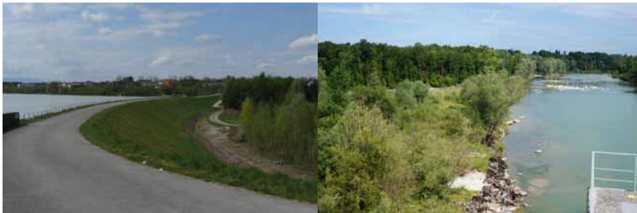
Abbildung 141: Links: Linksufriger Damm zum Wehr Thaling, in der Mulde darunter ein kleines, häufig trocken fallendes Gerinne; Rechts: Blick ins linksufrige Unterwasser.
