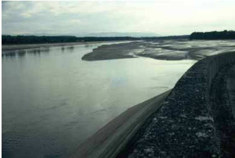
Abbildung 138: Sedimentpakete liegen weiter stromab in weiten Bereichen vor. Weit ausgedehnte Seichtzonen bieten Möglichkeiten für die Schaffung von Inseln.
