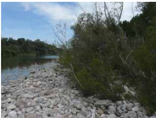
Abbildung 143: Schotterbank am rechten Ufer unterhalb der Autobahnbrücke: Lediglich Grobgeschiebe hält dem Ungleichgewicht von normaler Erosion und mangelnder Sedimentation stand.
