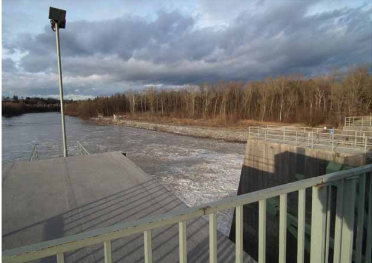
Foto A 87: Am KW Thaling, Blick auf die Restwasserstrecke bei ablaufendem Hochwasser, 15. 1. 2011. Rechtes Ufer hart befestigt.
