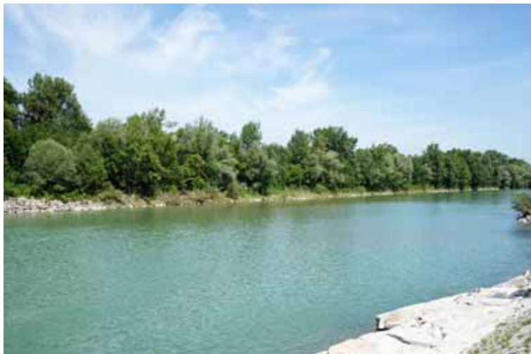
Abbildung 167: Blick ins rückgestaute Unterwasser des Hilfswehrs.
