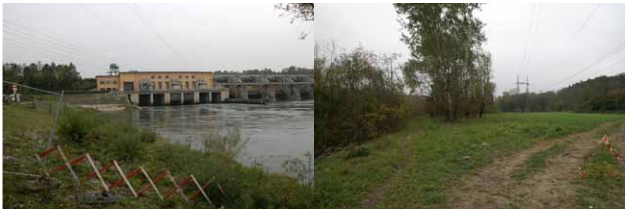
Abbildung 98: Gelände im Unterwasser KW Staning. Links: Blick stromauf; Rechts: Vorland, Blick stromab.
