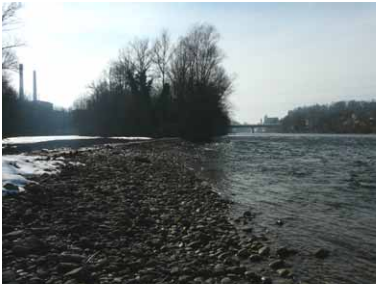
Abbildung 83: Flussabwärtiges Ende der Rederinsel mit Sohlgurt, der die Durchströmung bei Niederwasser unterbunden hat. Rechts die freie Fließstrecke des Hauptarms. In diesem Bereich war das Fließgefälle vor Umsetzung des HWSchPj beträchtlich.
