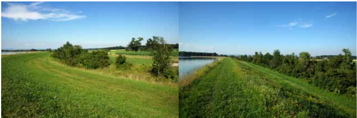
Abbildung 139: Links: Oberer Teil des Qualmgangs. Rechts: Blick vom Damm weiter stromab. Qualmgang im Gehölz rechts.
