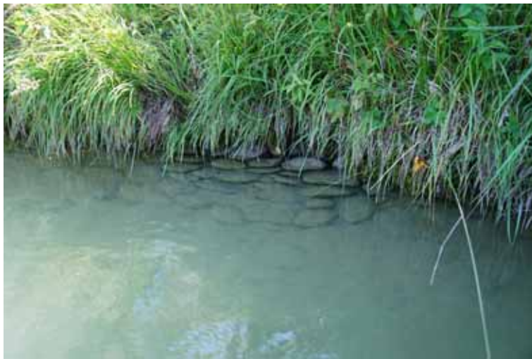
Abbildung 119: Altes Uferdeckwerk im Maßnahmenbereich.
