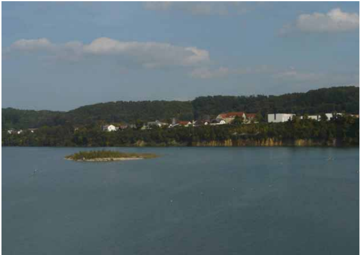
Foto A 45: Neue Insel und rechtsufrige Schlierwände bei Ramingdorf von der Nordspangenbrücke aus.
