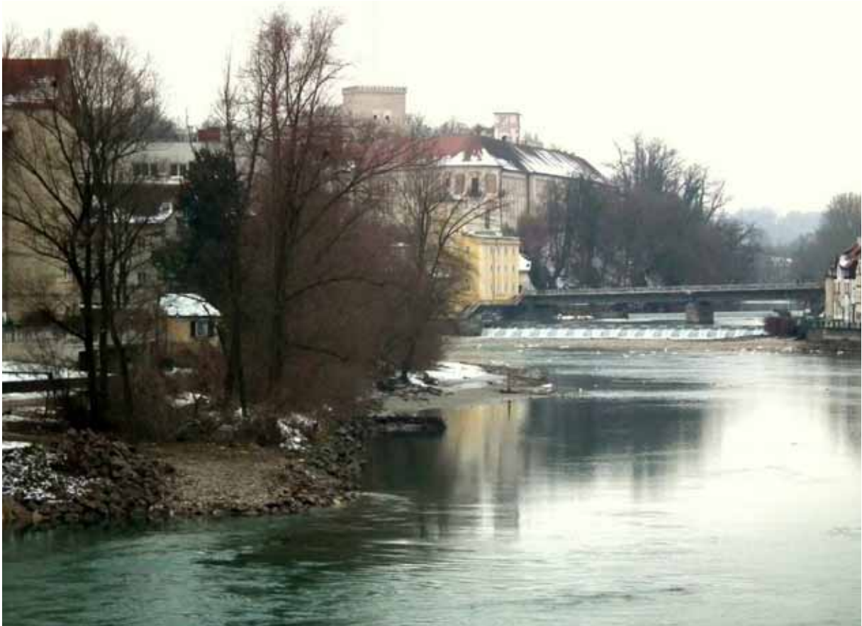
Foto A19: Vgl. Foto A 9: Nach Absenkung des Wasserspiegels ist die rechtsufrige Sandbank markanter und größer. Vgl. auch Foto A 15!
