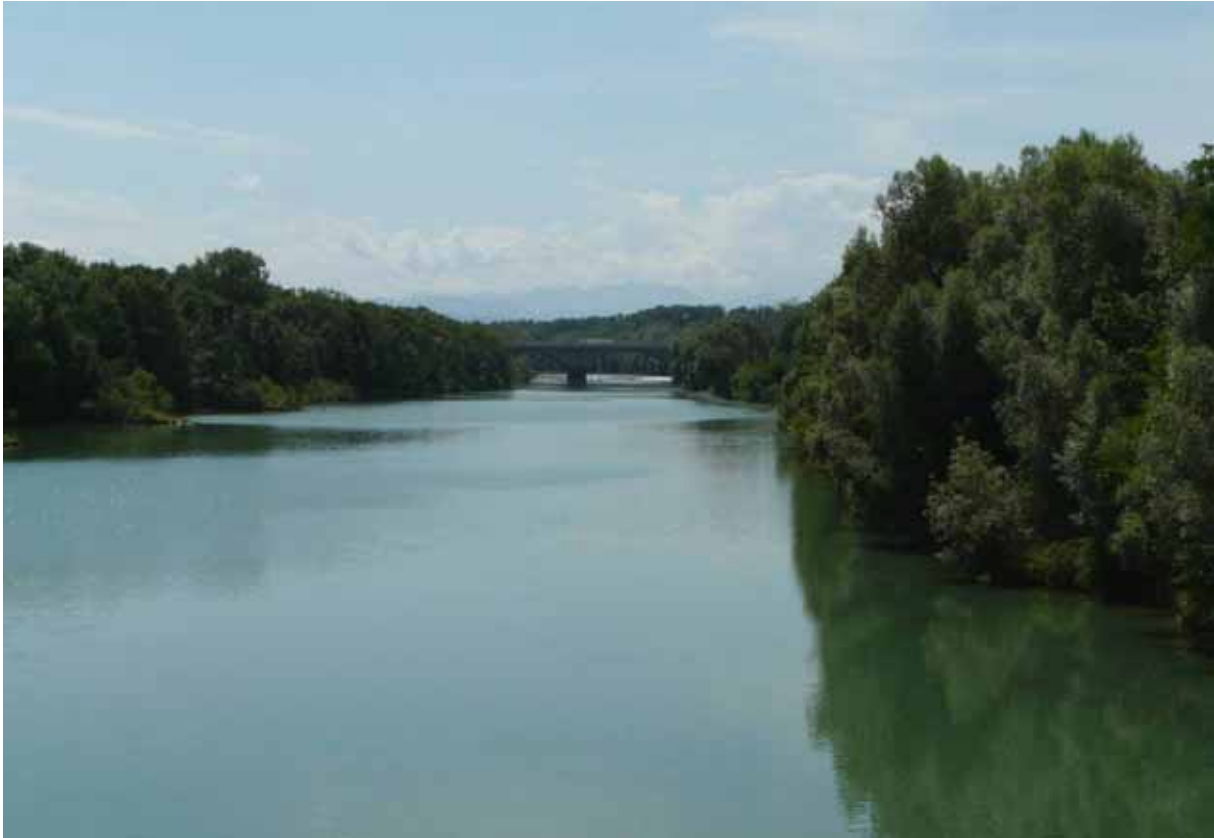
Foto A 101: Blick von der Brücke in Ennsdorf flussaufwärts. Das „Hilfswehr Enns“ gibt dem Abschnitt Staucharakter. Autobahnbrücke und zweites Streichwehr sind erkennbar.
