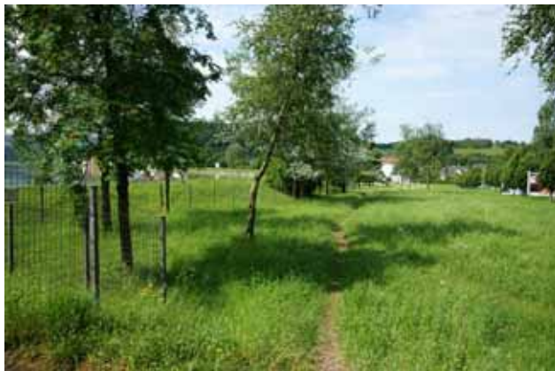
Abbildung 70: Damm und Vorland im Oberwasser.
