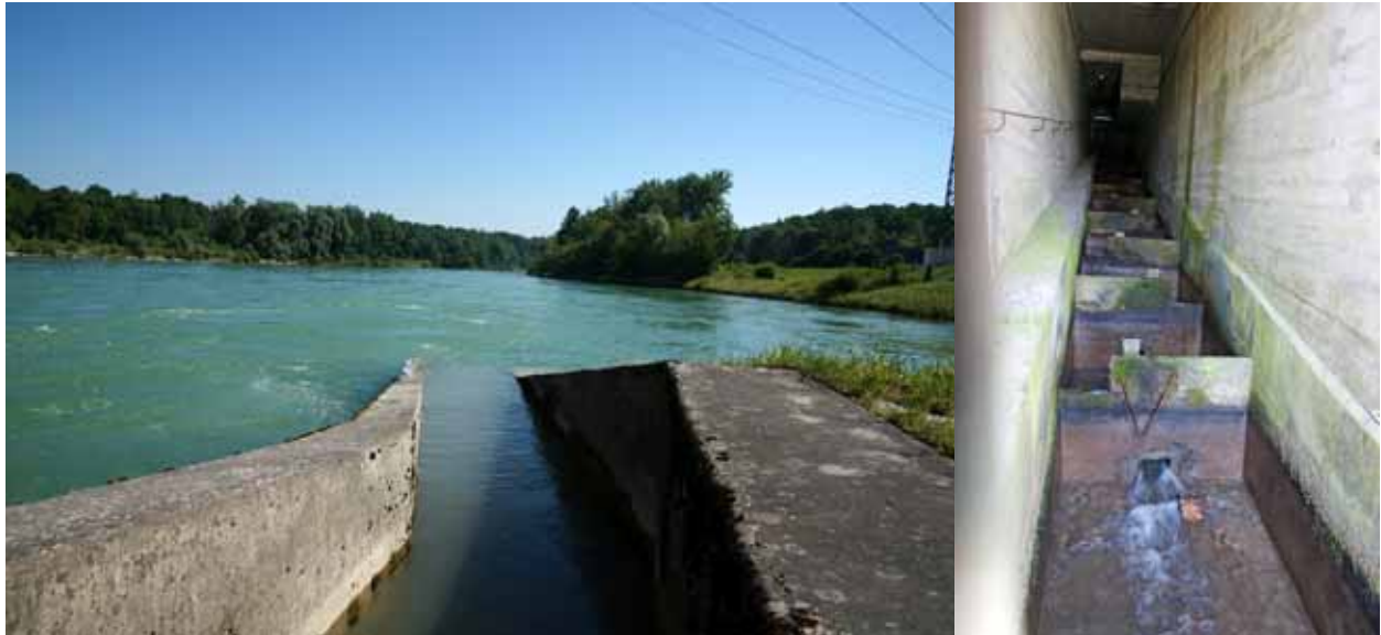
Abbildung 99: Einstieg in die bestehende, inaktive Fischaufstiegshilfe am KW Staning (links). Rechts: Blick in den FAH-Schacht im Kraftwerksinneren.
