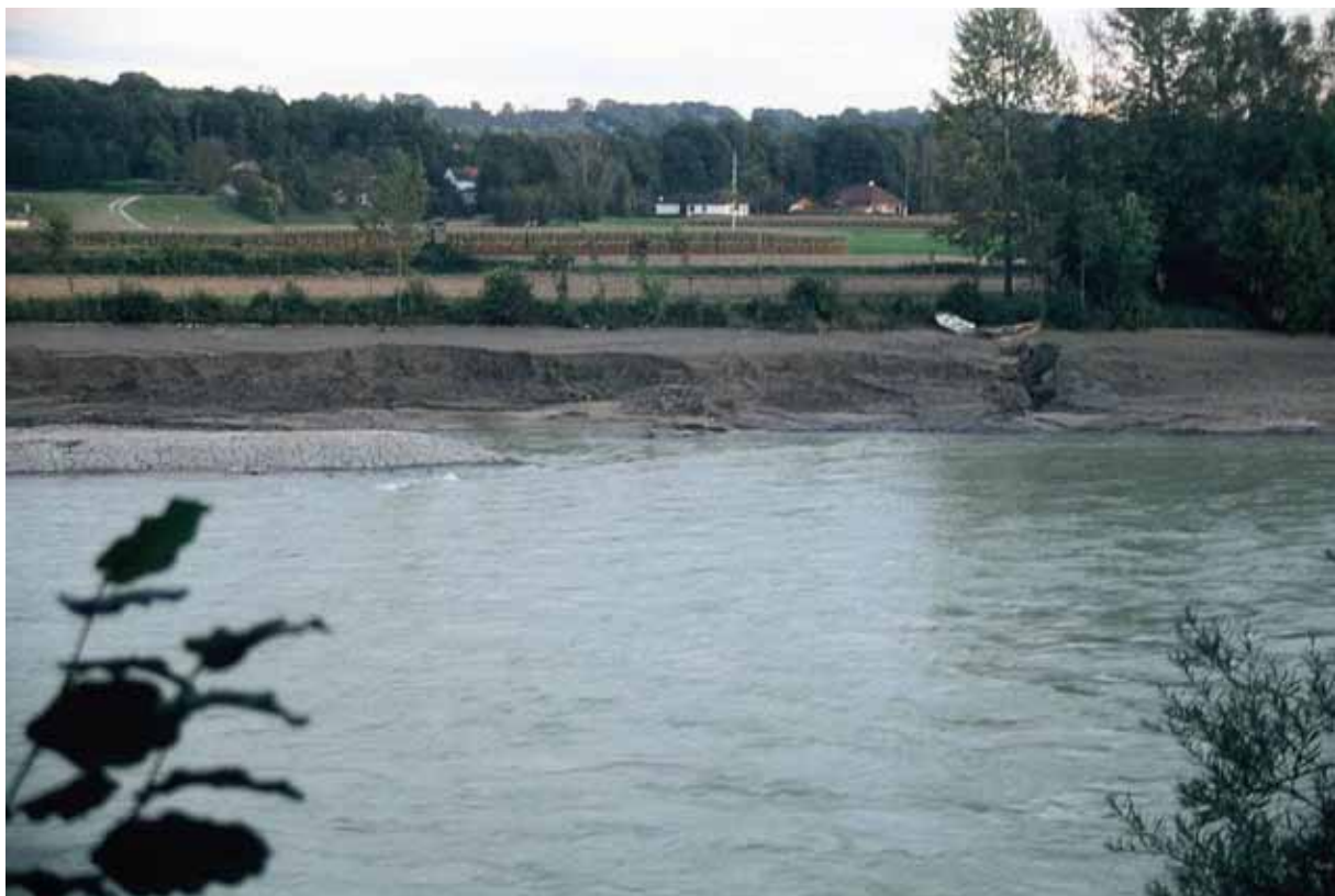
Foto A 76: Blick vom gleichen Standort quer über den Fluss, ebenfalls bei abgesenktem Stau.. Hier sind massive Feinsedimentablagerungen sichtbar, außerdem ein altes Regulierungsbauwerk.
