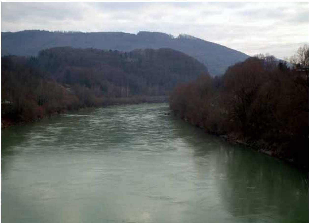
Foto A4: Blick von der Eisenbahnbrücke Garsten flussaufwärts. Die in Foto A2 flussabwärts erkennbare Flussbiegung versperrt hier den Blick auf das Kraftwerk Garsten, welches kurz dahinter liegt.
