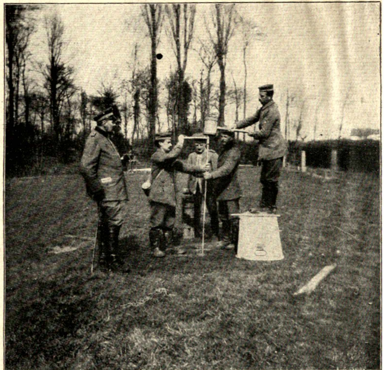
Abb. 2. Kriegsgeologische Bodenuntersuchung durch Abbohren. (Aufsuchen einer Sandanhäufung (Filter) in der Niederterrasse eines Flußtales, zwecks Trinkwasserbeschaffung.)
