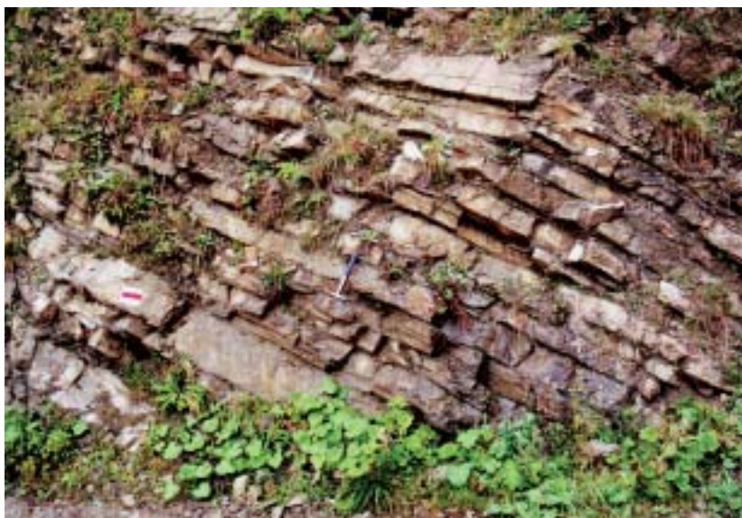
Abb. 10: Schön geschichtete Kalke der Unteren Allgäu-Schichten. Verursacht wird die gute Schichtung durch relativ weiche, dunkelbraun verwitternde Mergellagen, die zwischen den härteren hellbraunen Kalkbänken ausgebildet sind.
