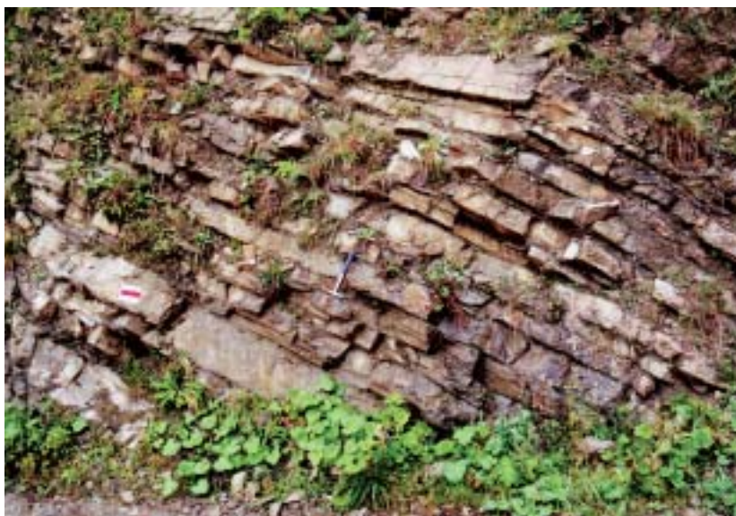
Abb. 10: Schön geschichtete Kalke der Unteren Allgäu-Schichten. Verursacht wird die gute Schichtung durch relativ weiche, dunkelbraun verwitternde Mergellagen, die zwischen den härteren hellbraunen Kalkbänken ausgebildet sind.
