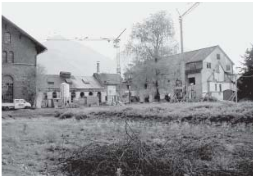
Abb. 1: Das ehemalige Rüscherwerk-Areal mitten im Umbau.
