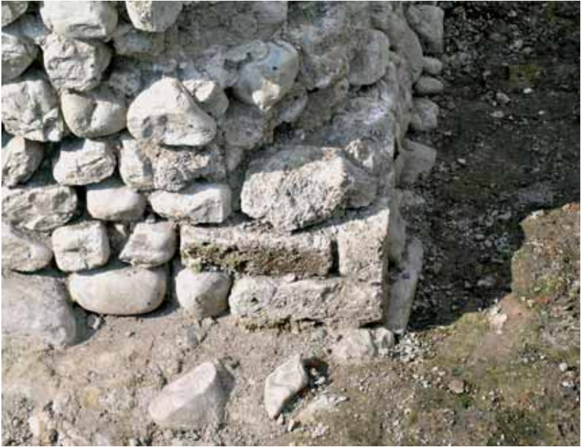
Abb. 21: Römervilla Rankweil, Mauereck aus Quelltuff
