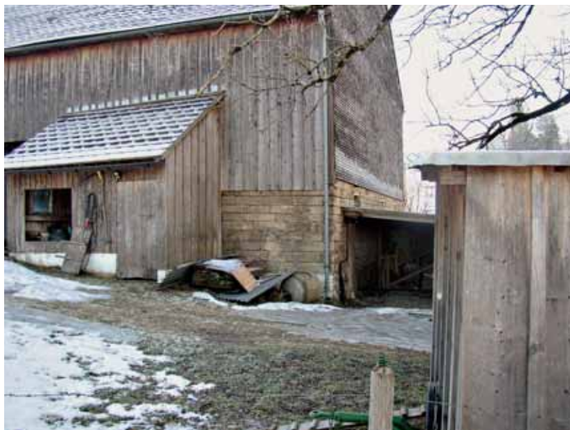
Abb. 23: Bauernhaus in Andelsbuch, Stallmauern aus «Tugstein» (Quelltuff)
