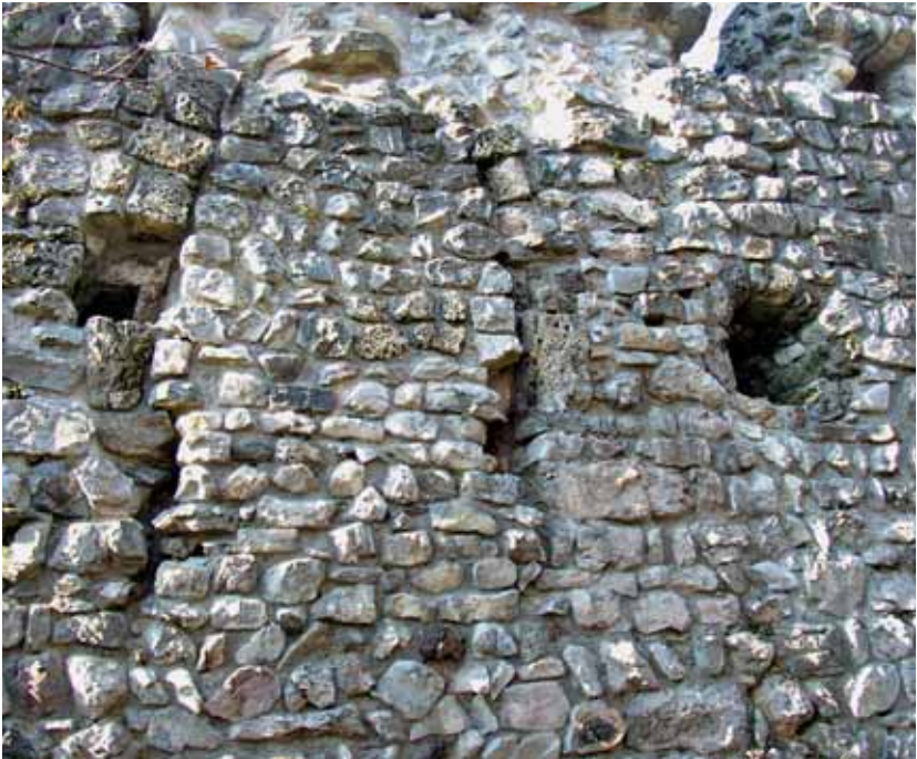
Abb. 22: Ruine Neuburg, Elemente aus Quelltuff
