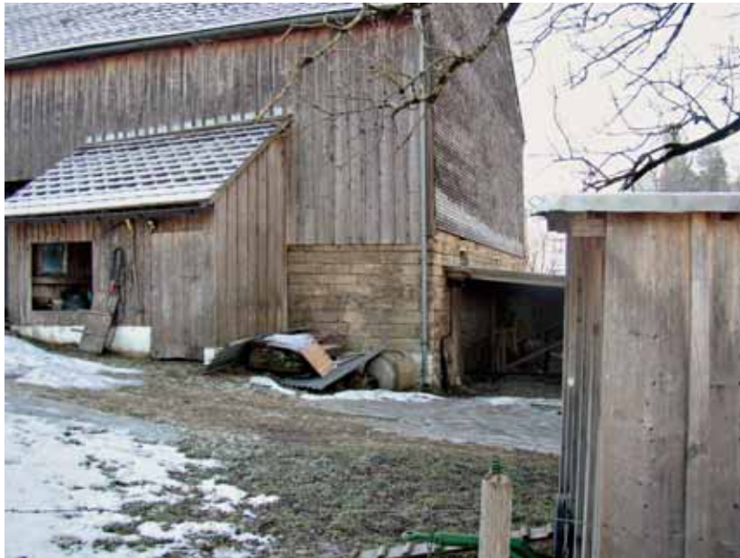
Abb. 23: Bauernhaus in Andelsbuch, Stallmauern aus «Tugstein» (Quelltuff)
