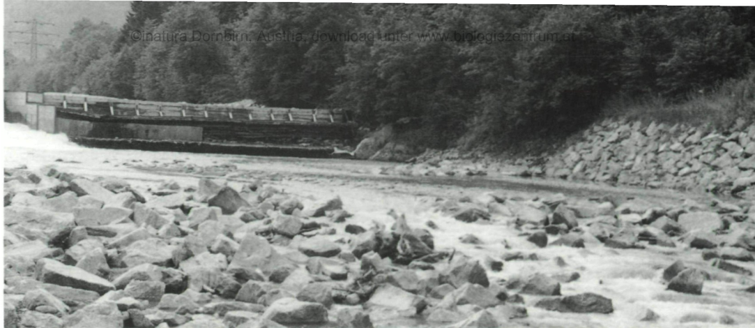
Abb. 28: Das Wasser der Ill wird vor Bludenz zur industriellen Nutzung durch einen Kanal abgeleitet. Das Ufer (am Waldrand) ist mit einer Steinschichtung verbaut (Foto: E. Schneider)
