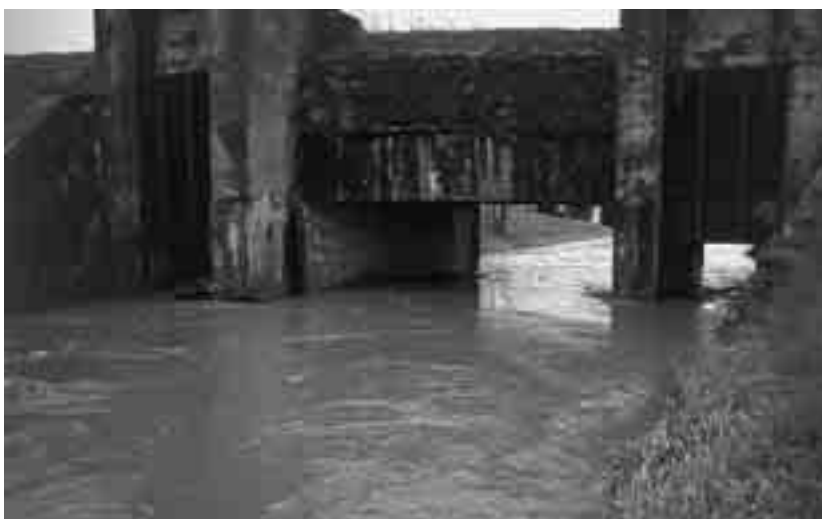
Abb. 1: Die Seelachenschleuse, einst zum Schutz der Gemeinde Lustenau vor Überflutungen errichtet, mußte dem Ausbau des Rheintal-Binnenkanales weichen
