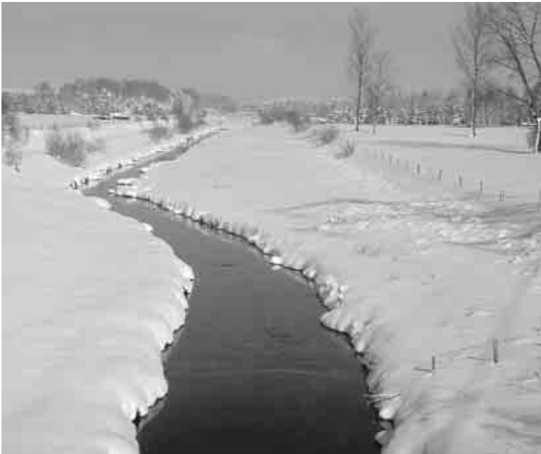
Abb. 6: Der neugestaltete Rheintal-Binnenkanal. Die einst geradlinigen Ufer wurden durch Kieseinschüttungen naturnäher gestaltet
