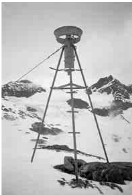
Abbildung 3: Totalisator Vermuntgletscher. Im Hintergrund der Eisbruch des Ochsen-taler Gletschers
