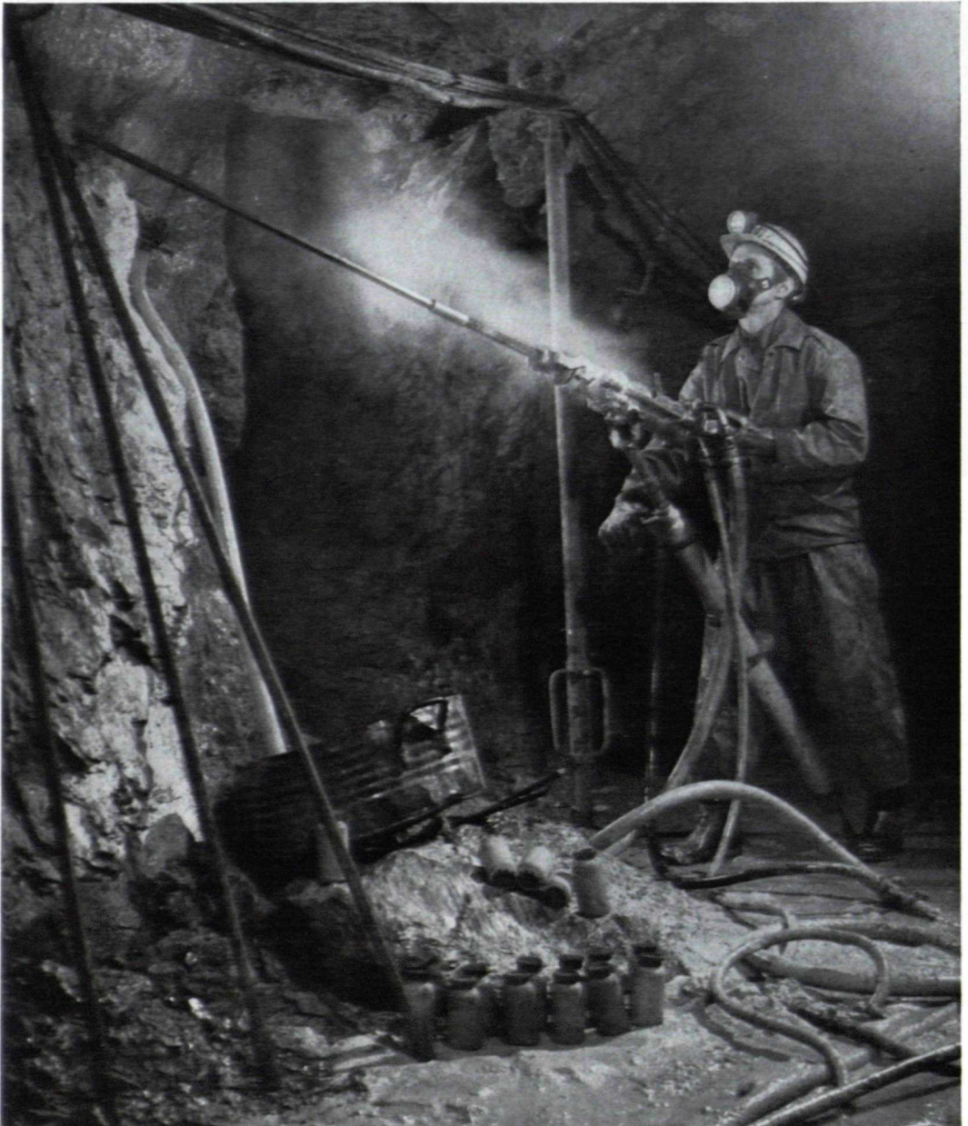
Abb. 8. Proben-Entnahme, Bohrungen ersetzen die teuren Aufklärungsstrecken
