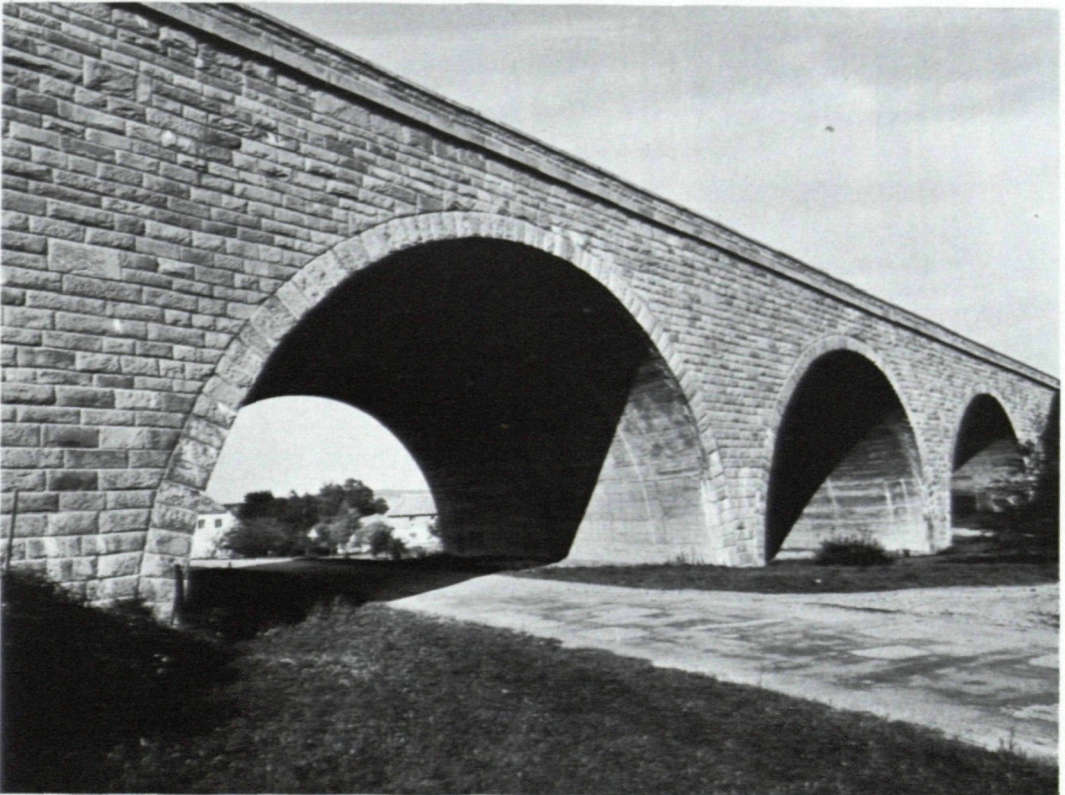
Abb. 4. Autobahnunterführung bei Böheimkirchen, Niederösterreich. Flysch-Sandstein. (Foto: NÖ Bildstelle Gmeiner)
