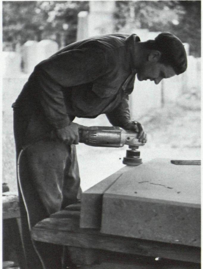
Abb. 21. Steinbearbeitung mit biegsamer Welle. (Verlag des ÖGB)
