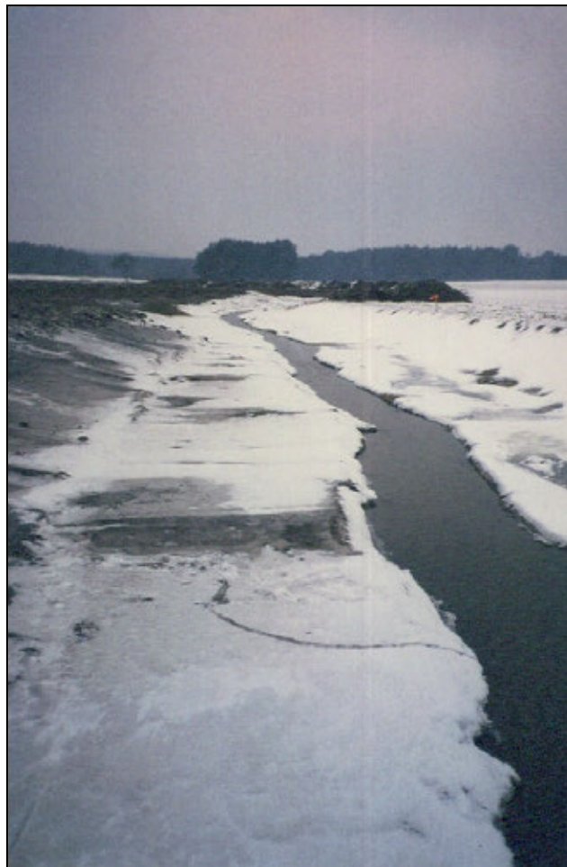
Abb. 5: Der Sprengbach im Dezember 1998: Die Verrohrung wurde entnommen, ein neues Gewässerbett gestaltet, die Drainagen außer Funktion gesetzt (Foto VNP-Archiv).
