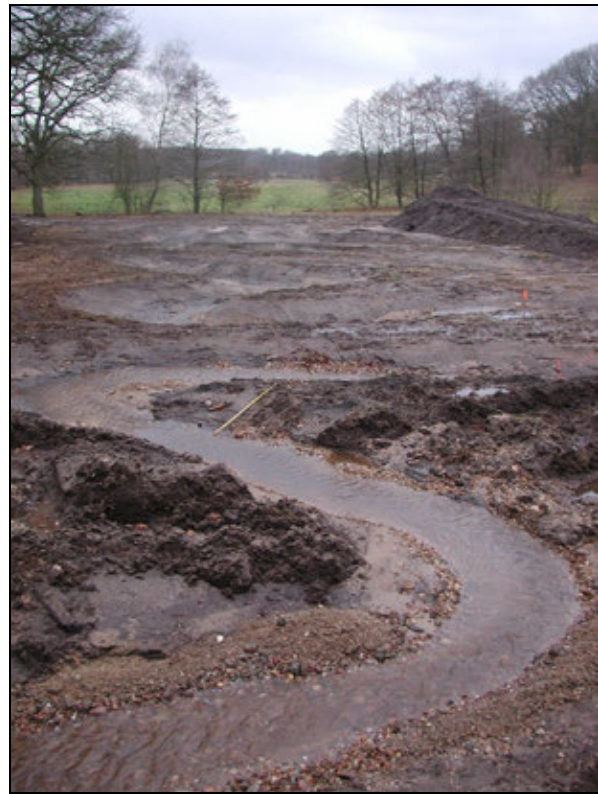
Abb. 21: Zustand der Haverbeeke unterhalb des Teiches direkt nach der Renaturierungsmaßnahme: In weiten Mäanderschleifen wird das starke Gefälle aufgefangen (Foto VNP-Archiv).
