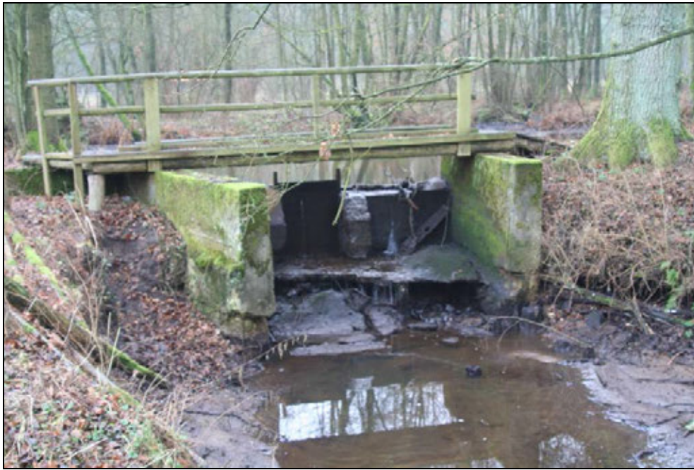
Abb. 12: Aus dem Rückstaubereich des Teiches im Erlenbruchwald zweigt ein Überlauf in das ursprüngliche Bachbett der Schmalen Aue ab (Foto VNP-Archiv, Dezember 2006).
