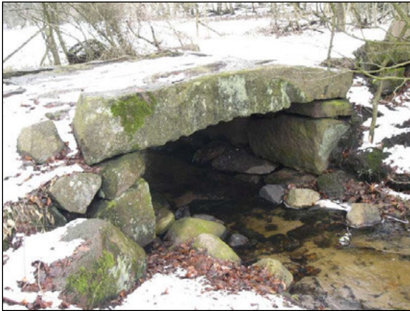
Abb. 5: Granitbrücke aus gespaltenen Findlingen bei Niederhaverbeck (Foto G. Grünhagen).
