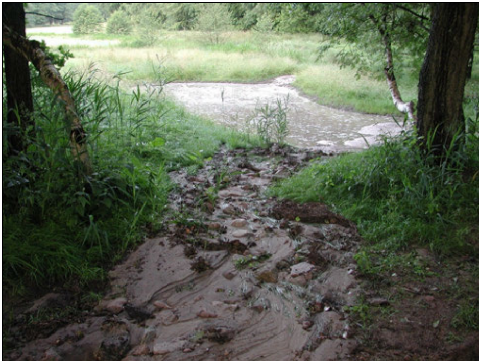
Abb. 18: Auf die massiven Sandeinträge in die Haverbeeke wurde mit der Einrichtung von Sandfängen reagiert (Foto VNP-Archiv, Juni 2003).
