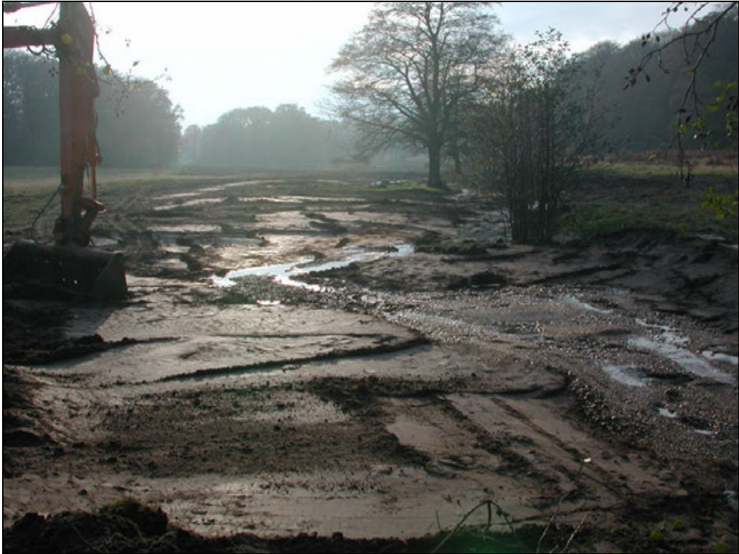
Abb. 14: Renaturierungsarbeiten am Wilseder Bach (Foto VNP-Archiv, 2003).
