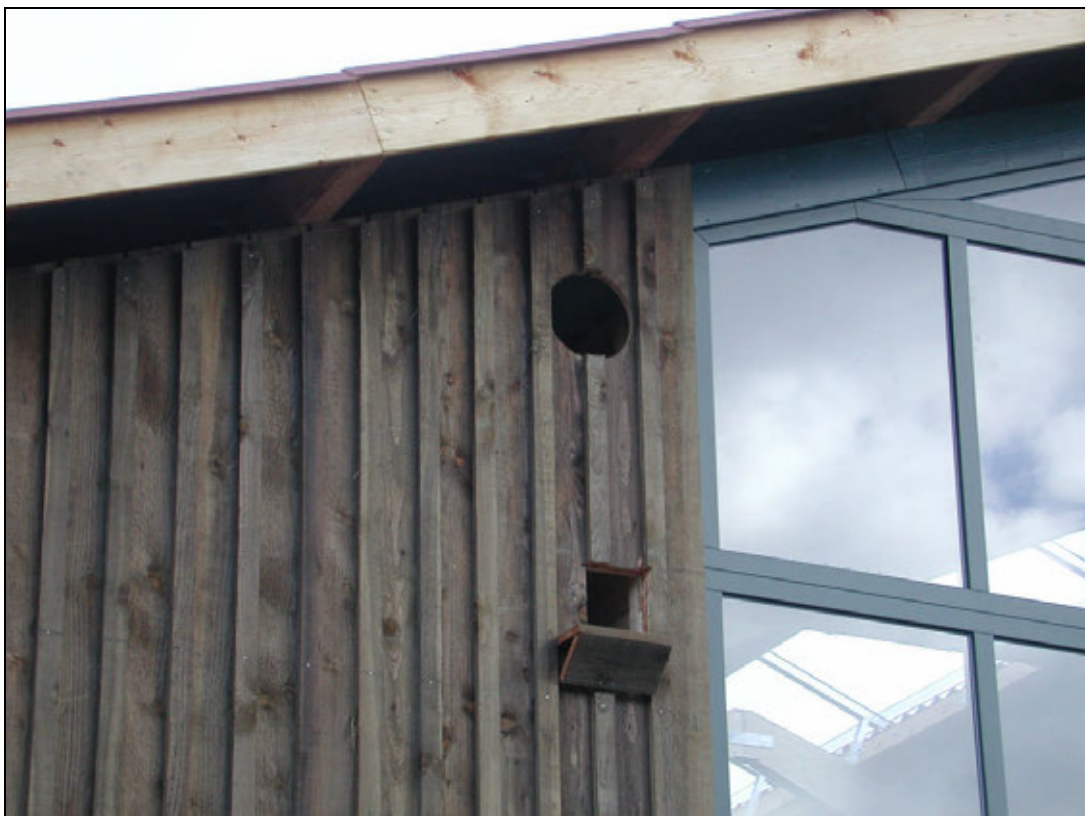
Abb. 4: Einbau eines von innen angebrachten Schleiereulen-Kastens im 2003 neu erbauten Schafstall auf dem VNP-Landschaftspflegehof Tütsberg.
