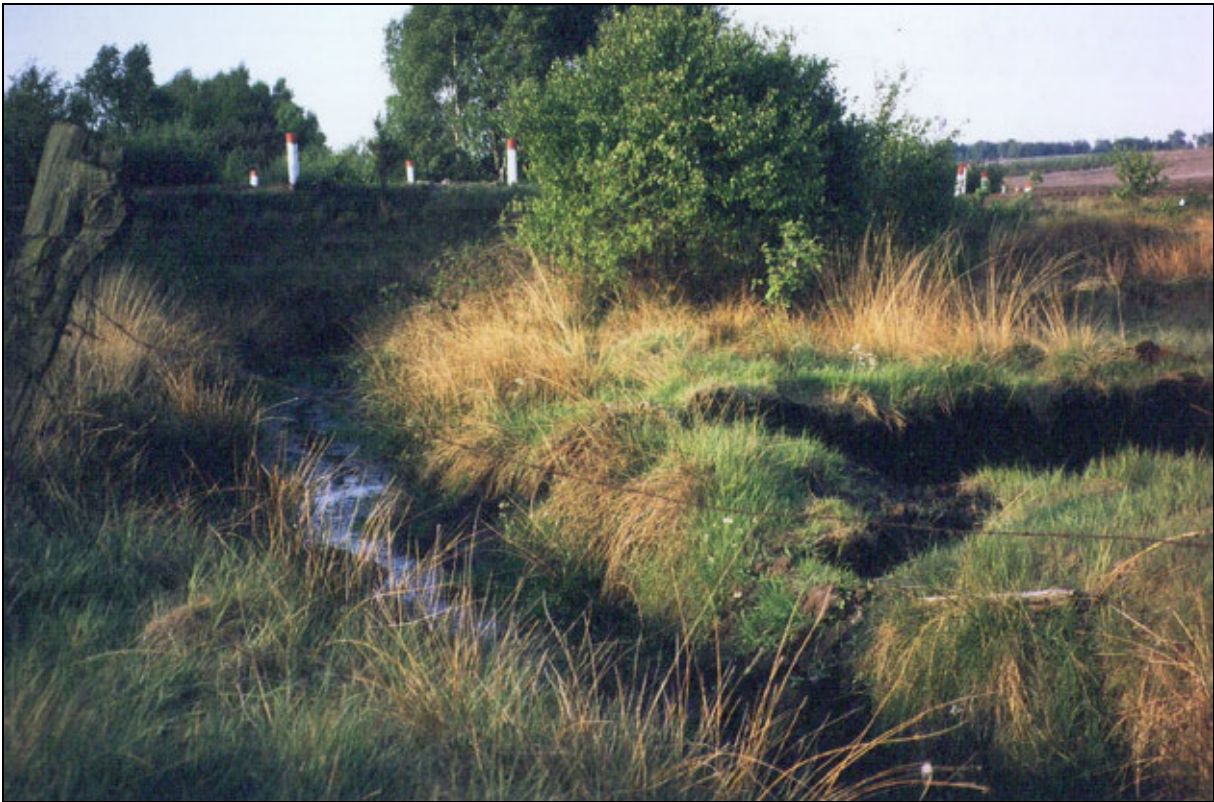
Abb. 3: Nördliche Panzerüberfahrt an der Brunau vor ihrem Rückbau (Foto NNA-Archiv, Mai 1993).
