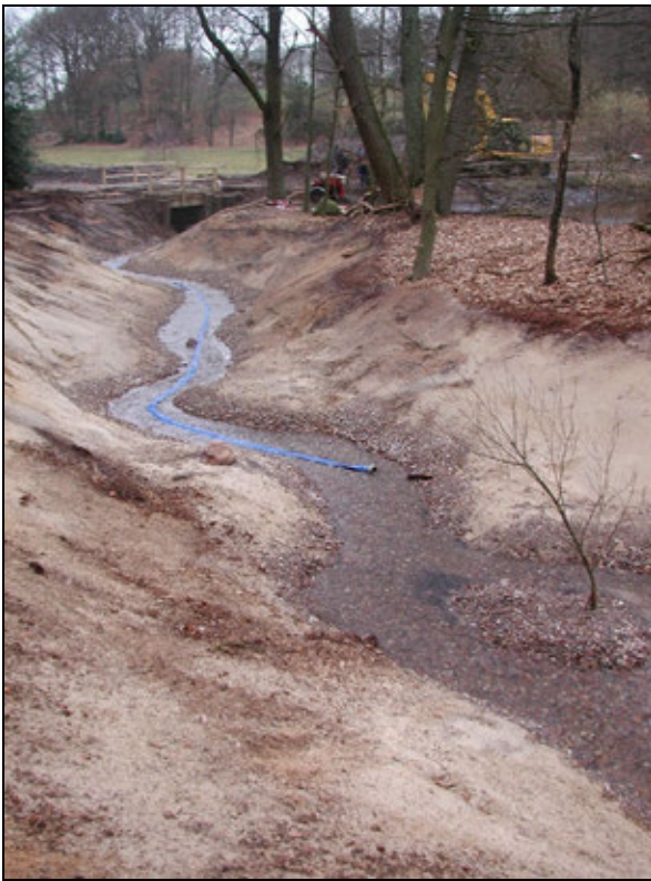
Abb. 20: Im Hintergrund die Querung des Rollstuhlwanderweges und vorn das im Bau befindliche Umflutgerinne mit deutlich sichtbarem Kiesbett (Foto VNP-Archiv).
