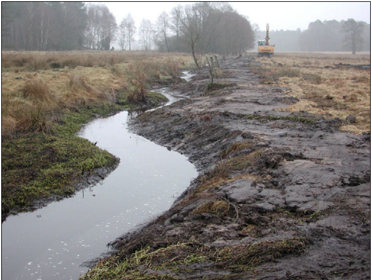
Abb. 16: Unterhaltungsarbeiten am Wehlener Moorbach (Foto VNP-Archiv, März 2003).
